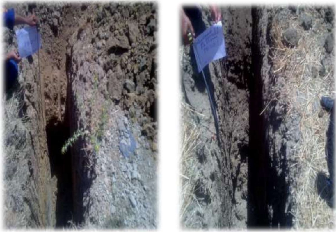
Figure V- 3 : Puits de reconnaissance
