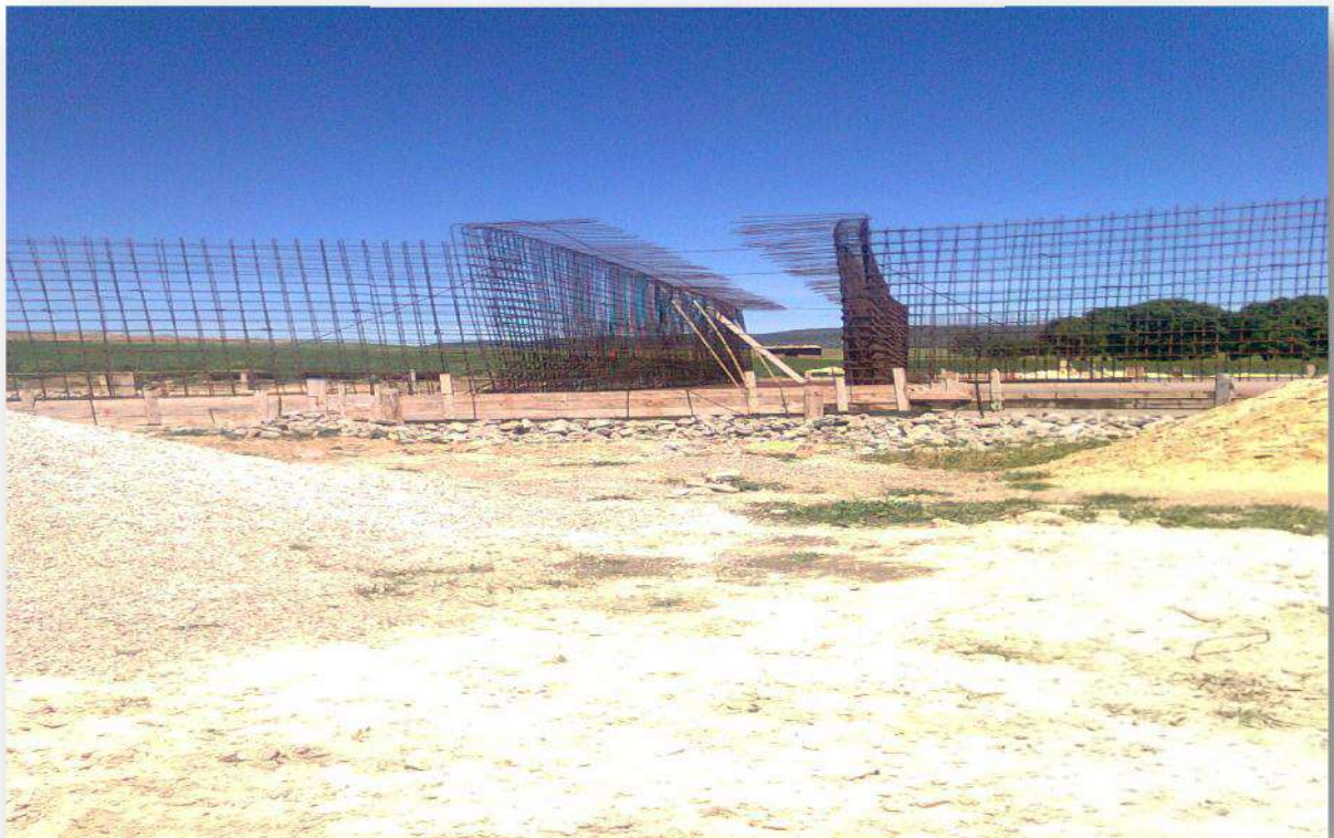
Figure.I.4. Un dalot bicellulaire au niveau des travaux.
