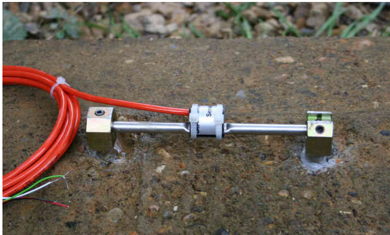
Figure III. 4: Jauge de contrainte montée sur le béton.
