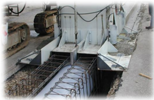
Figure 10.5 : mis en place des réseaux sous TPC
