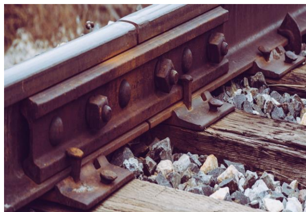
Figure IV.6: Assemblage des rails par éclissage
