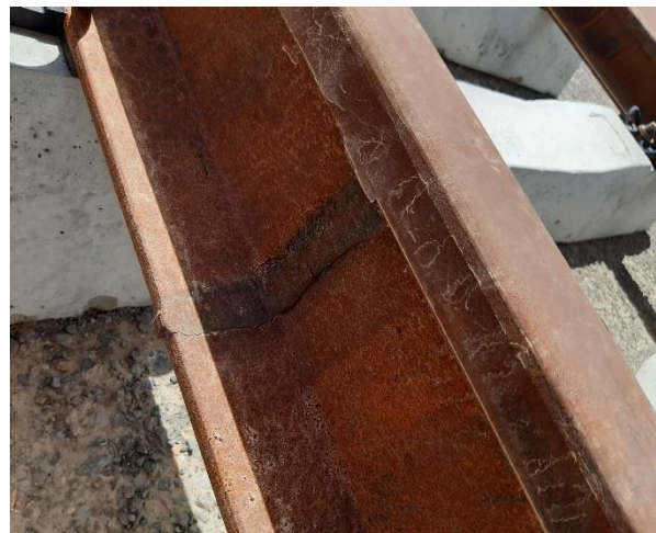
Figure IV.7: Soudure des LRS
