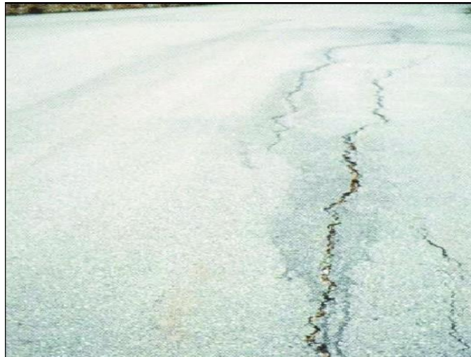
Figure I-2 : Fissure longitudinale.
