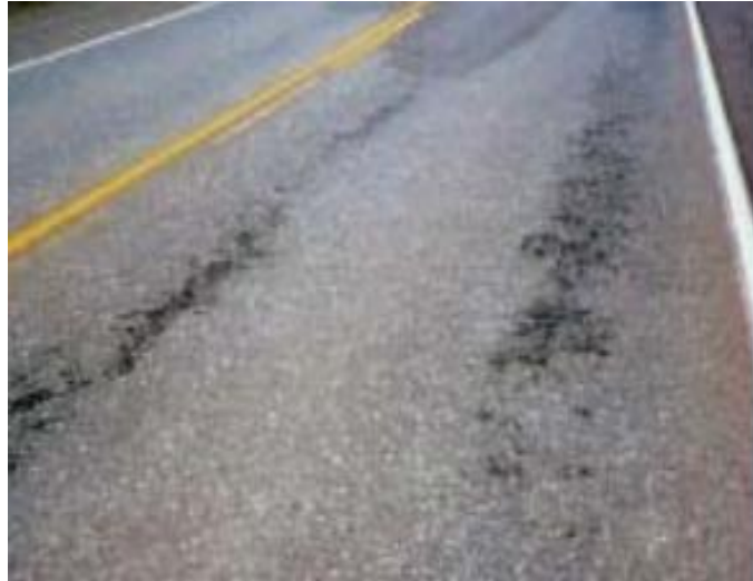
Figure I-6 : Dés enrobage et arrachement.
