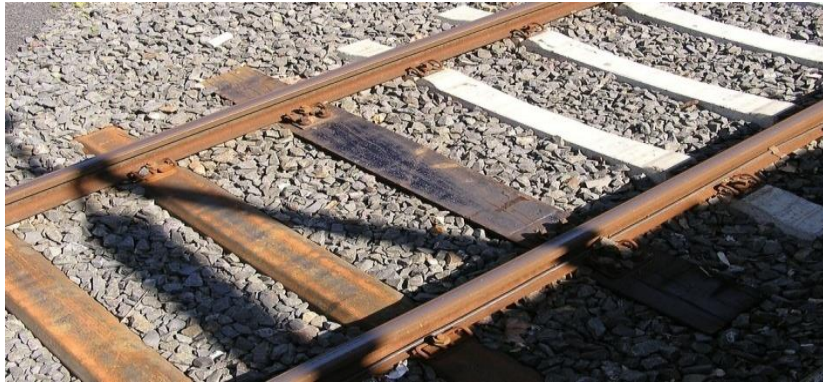
Figure 11 : Traverses métallique
