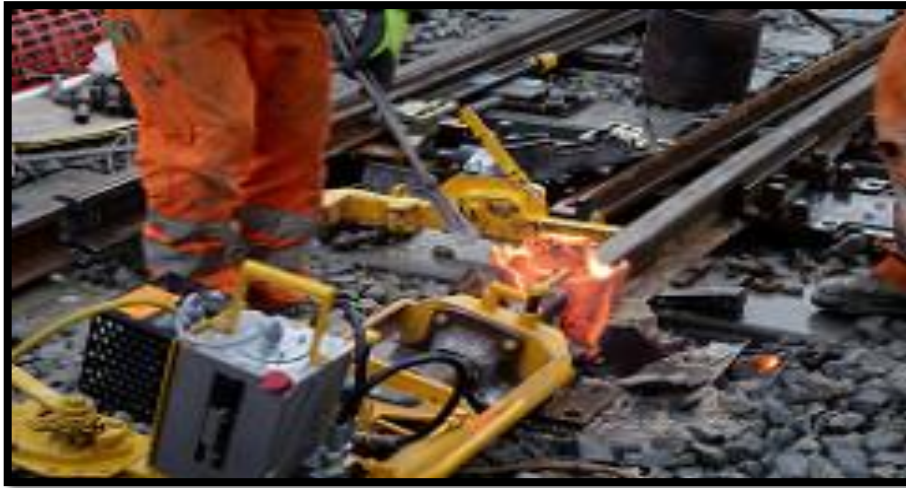
Figure 4: soudure aluminothermique
