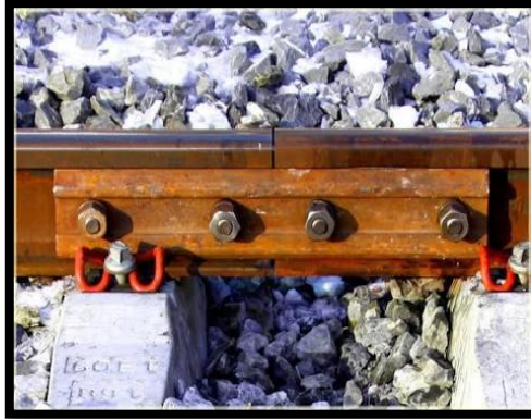
Figure 8 : Eclissage des rails
