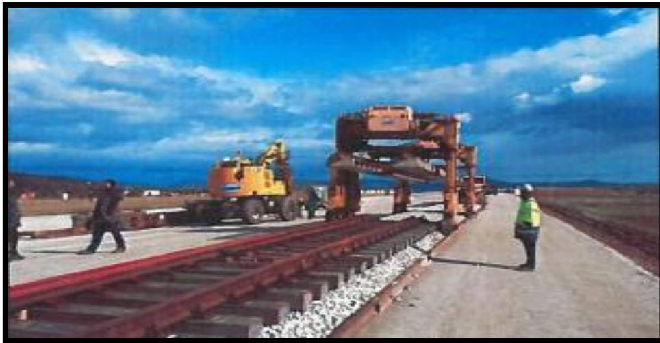
Figure 21: Pose de voie
