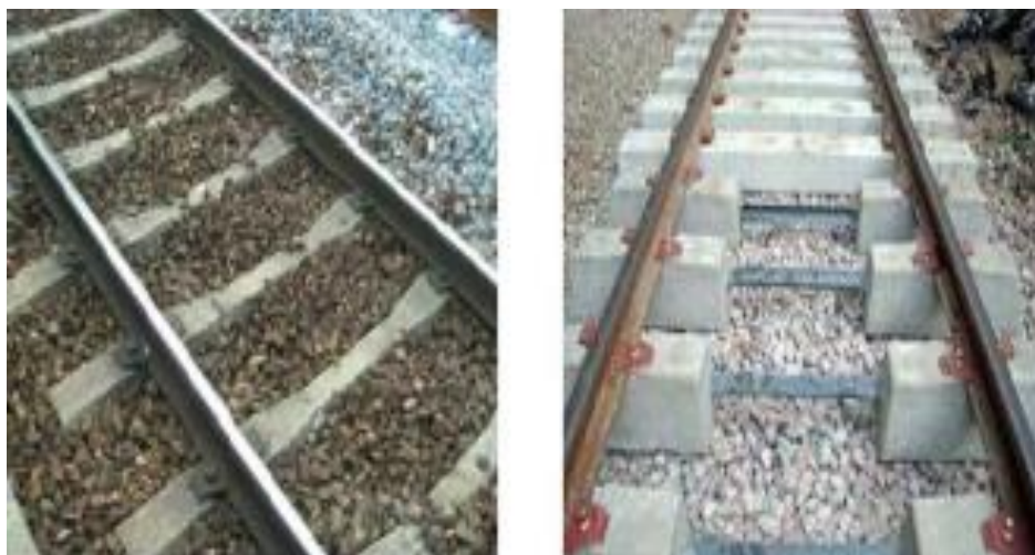
Figure 12 : Travers en béton monoblocs et bi-bloc
