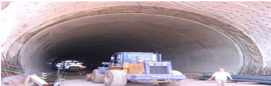
Figure I.19 Revêtement pour protéger l'étanchéité
