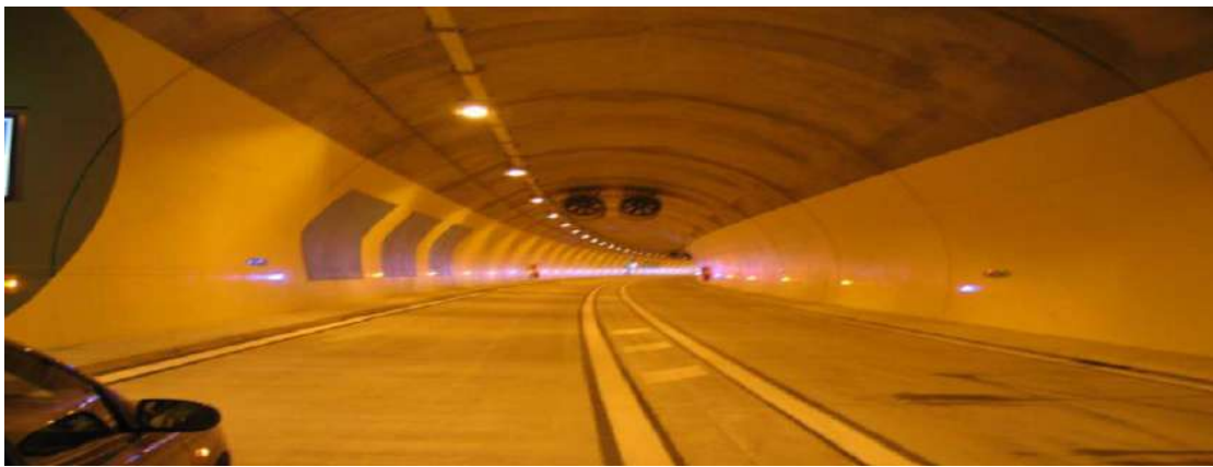
Figure I.22 Revêtement pour le confort des usagers
