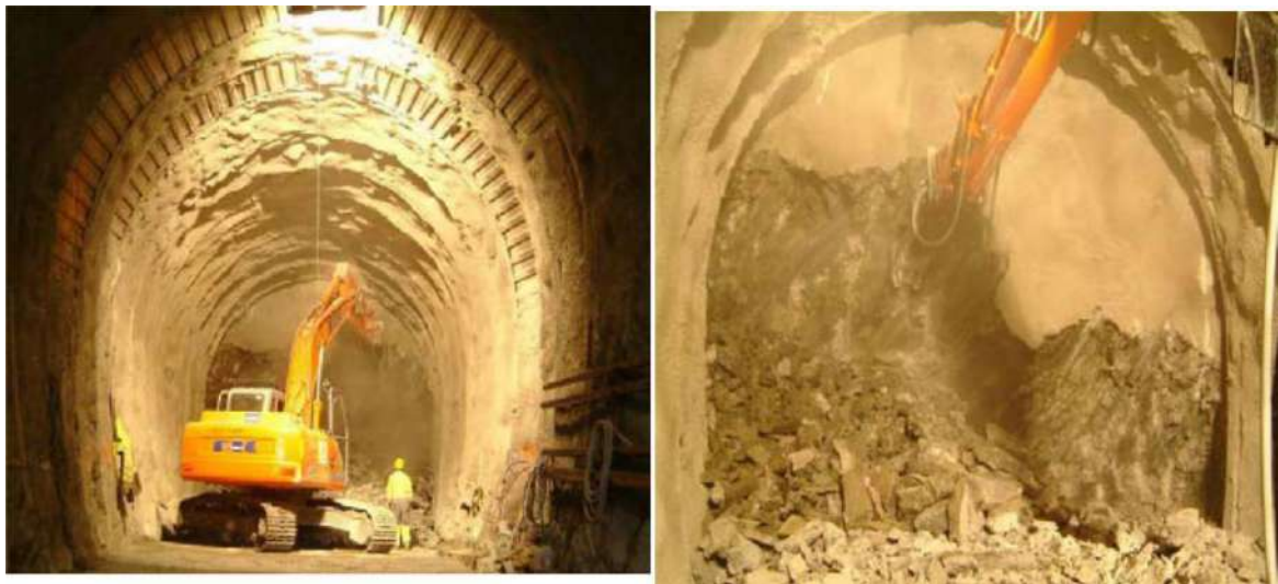
Figure I.10 Pelle Equipée d'un BRH ou d'un Godet d'Excavation
