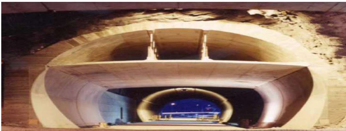
Figure I.20 Revêtement de support
