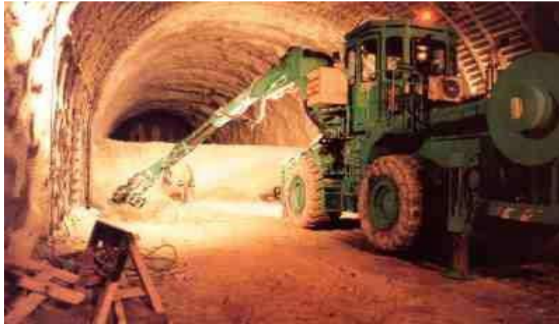
Figure I. 5. Creusement en demi-section
