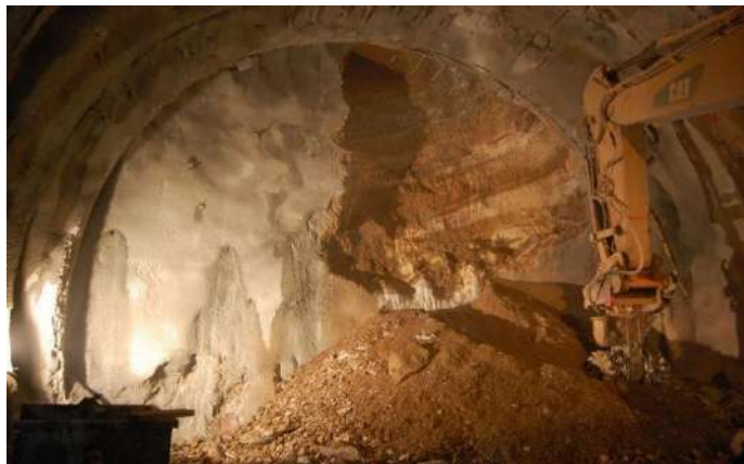
Figure I.4. Creusement à pleine section
