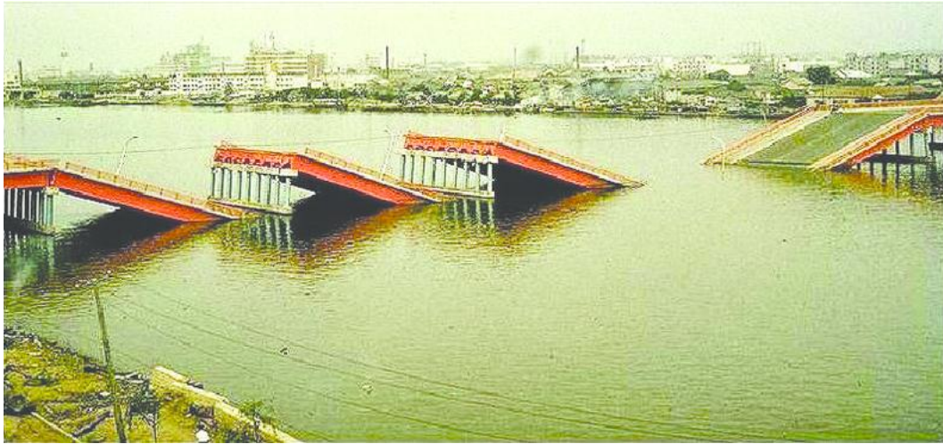
Figure I-10. Show Bridge suite au séisme de Niigata, 1964 [6]
