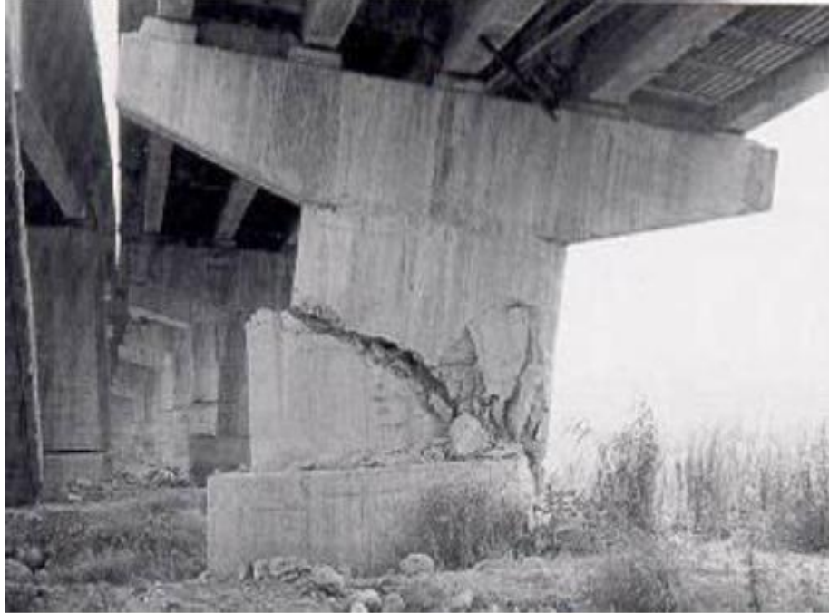
Figure I-5 Rupture des piles par cisaillement [1]
