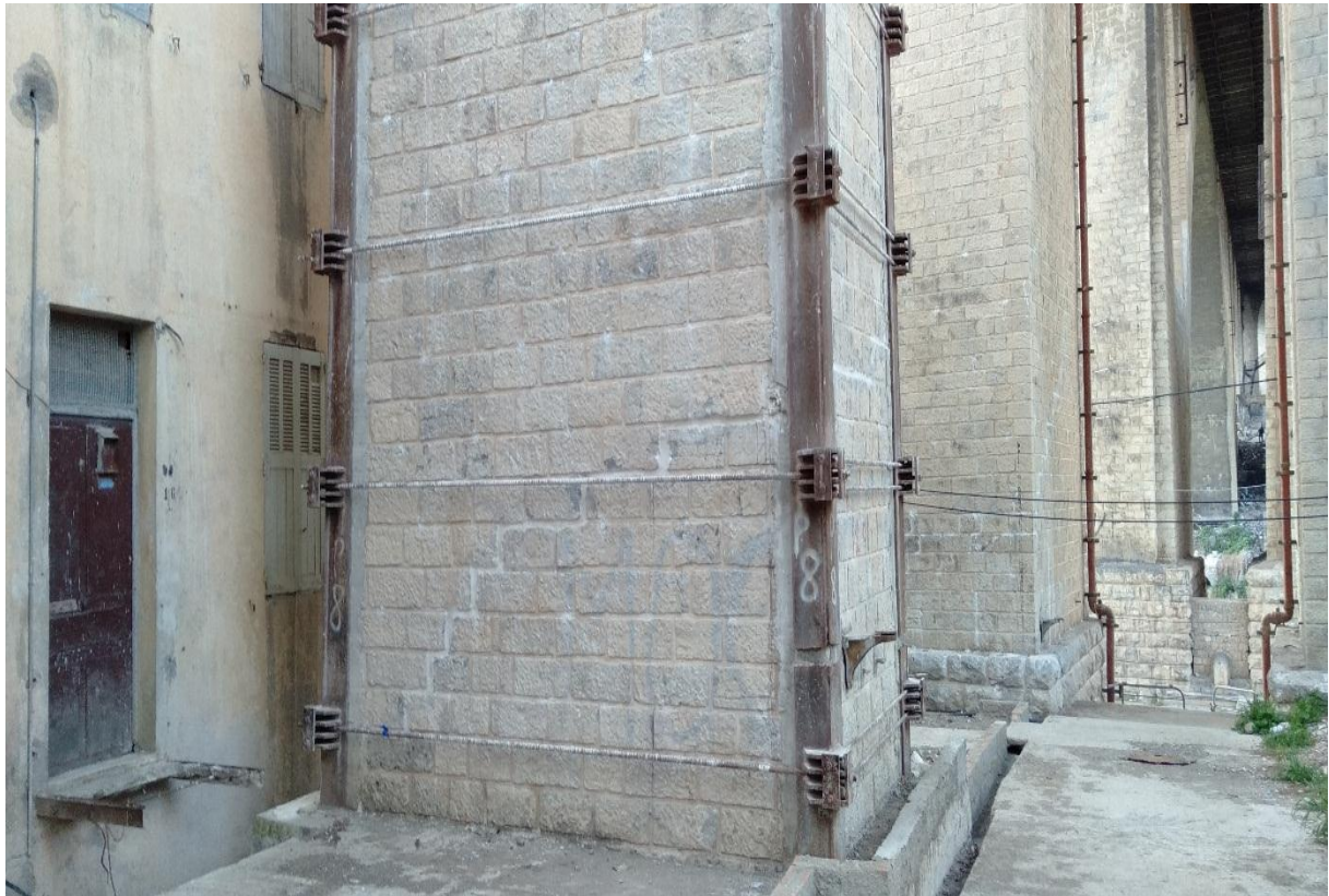
Figure I-17 Pile N°8 du pont de Sidi Rached - Constantine
