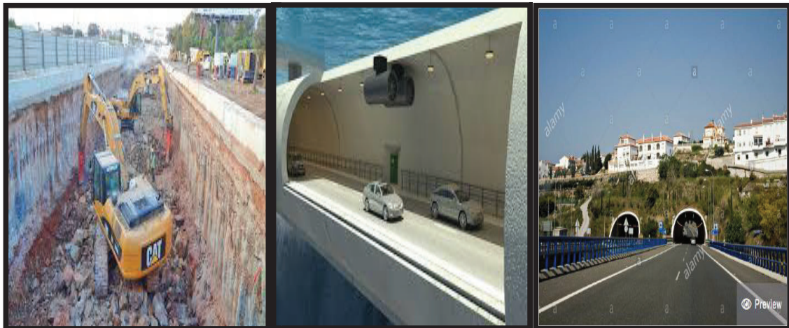
Tunnel a' ciel ouvert
