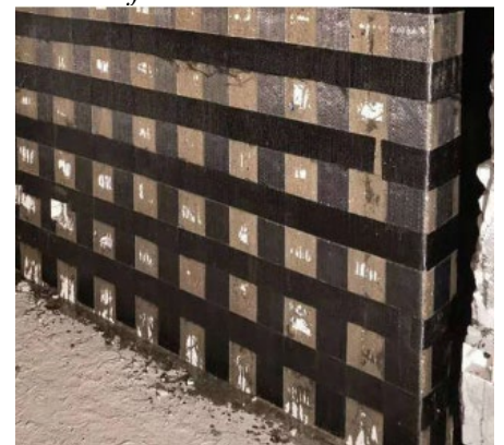
Figure 59: Renforcement des murs par fibres de carbone
