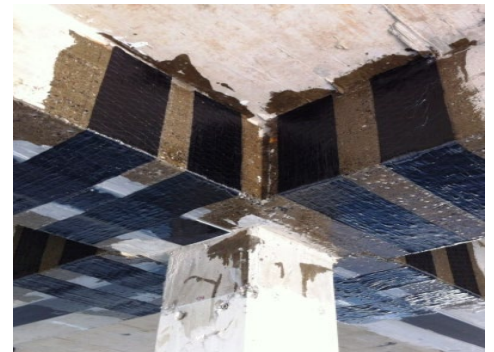
Figure 58: Renforcement des poutres par fibres de carbone
