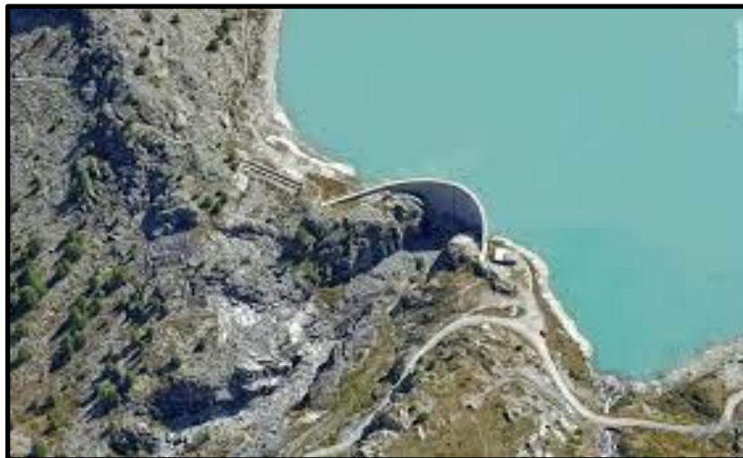
Figure I.12 : Barrage de Tourtemagne construit par post-contrainte.
