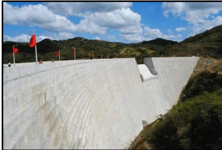
Figure I.10 : Barrage en BCR- cas du barrage de Portugués au Porto Rico.
