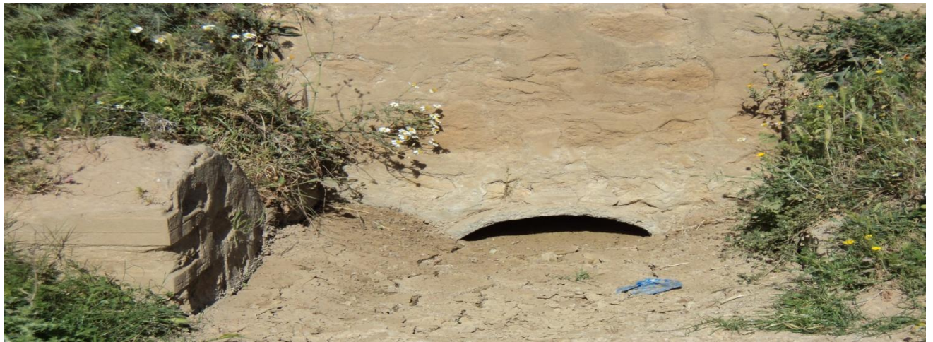
Photo sur état actuel du réseau d'assainissement.
