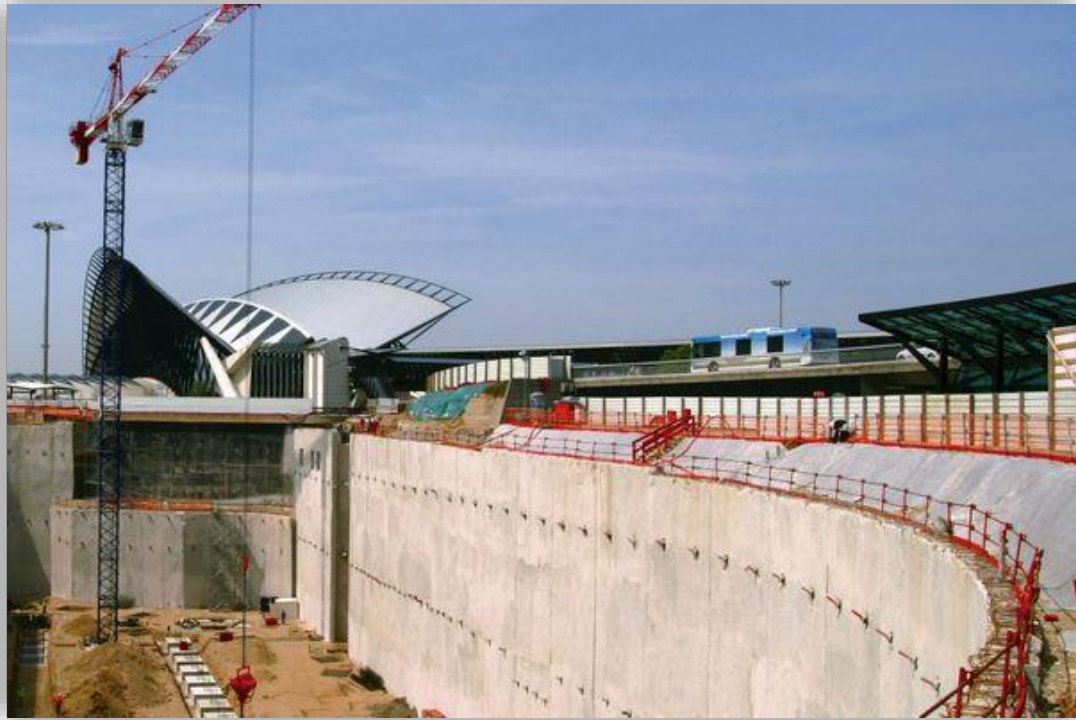
Figure 18. Blindage par parois moulées
