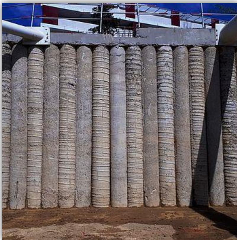
Figure 17. Blindage par Pieux sécants
