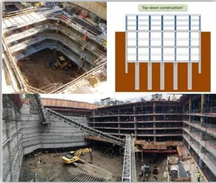
Figure 8. Méthode d'excavation top down
