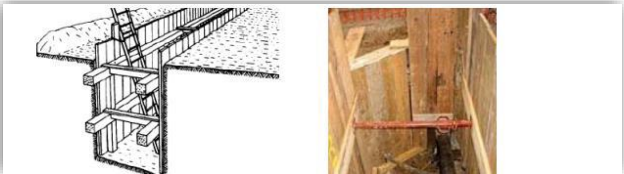
Figure 9. Enfilages en planches verticales
