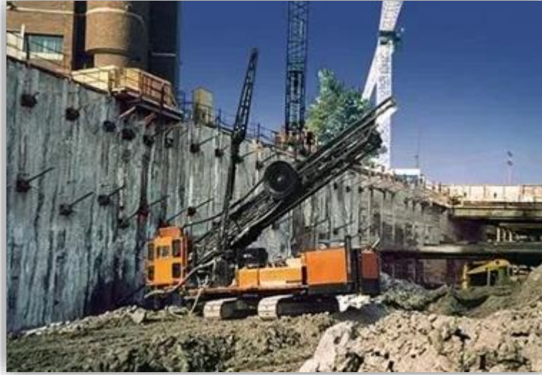
Figure 5. Méthode d'excavation ancrée
