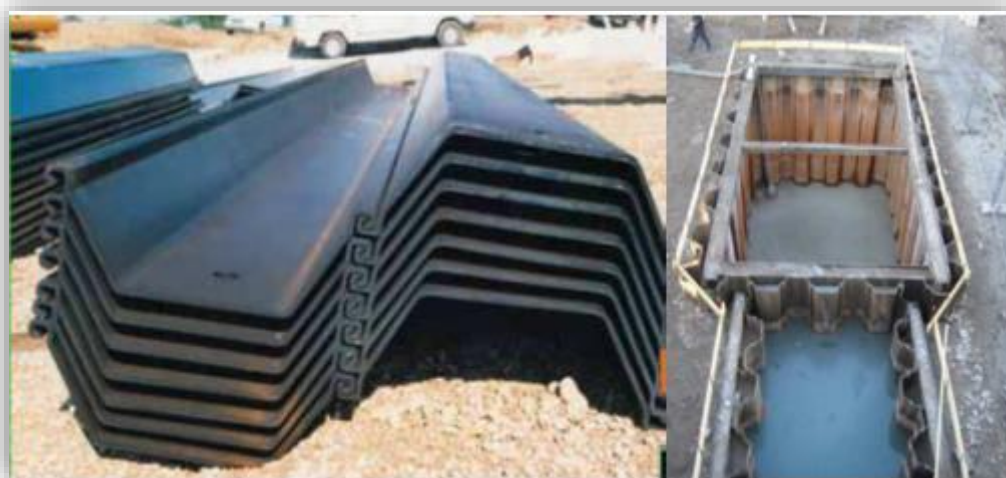
Figure 12. Blindage par Palplanches métalliques
