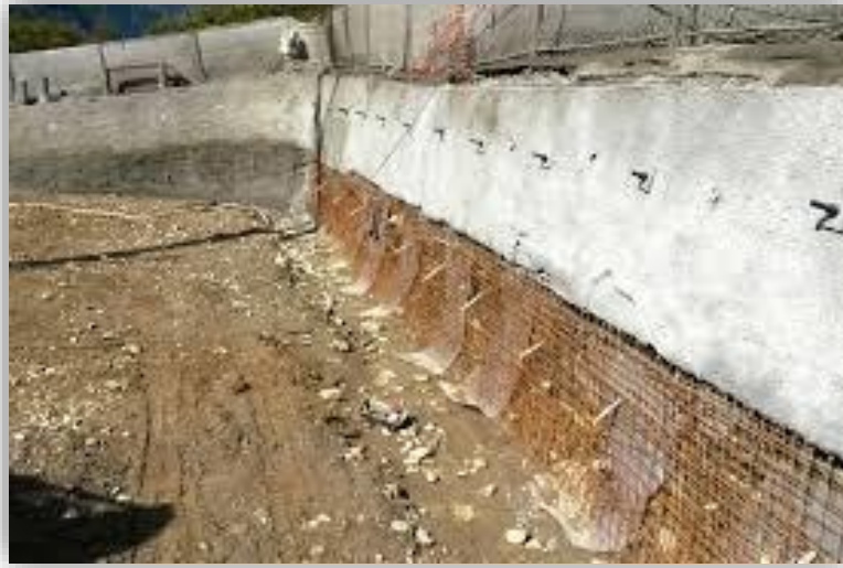
Figure 13. Blindage par Parois cloués
