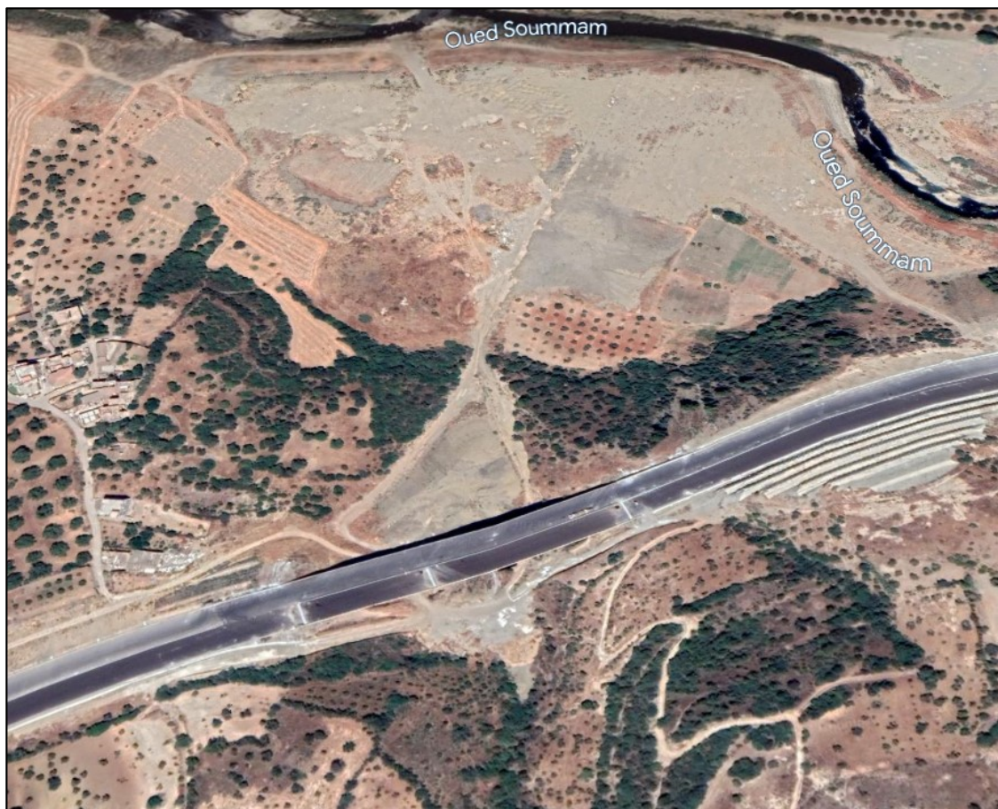
Figure I. 1 : Implantation de l'ouvrage sur Google Maps.
