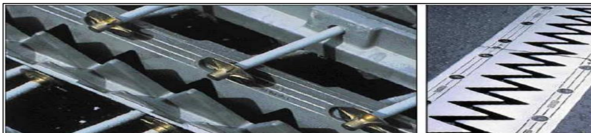
Figure IX. 5 : Joint de chaussée.
