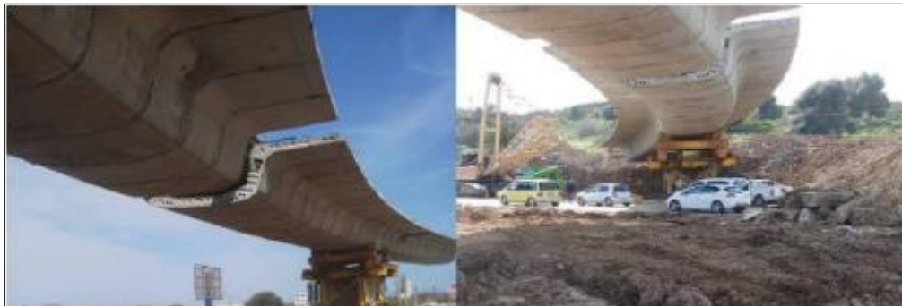
Figure III. 1: Technique de réalisation d'un pont caisson.
