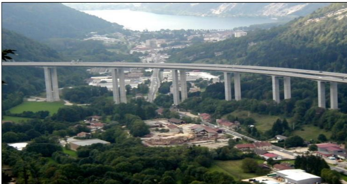
Figure 2 : Viaduc de Nantua, ouvrage sur l'A40, inauguré en 1988.
