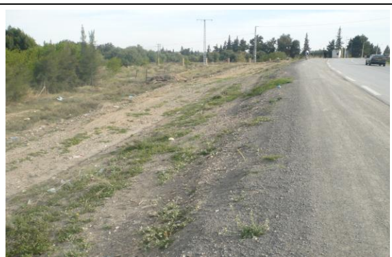
RN45AU PK 54+200 Chaussée en bon état.
