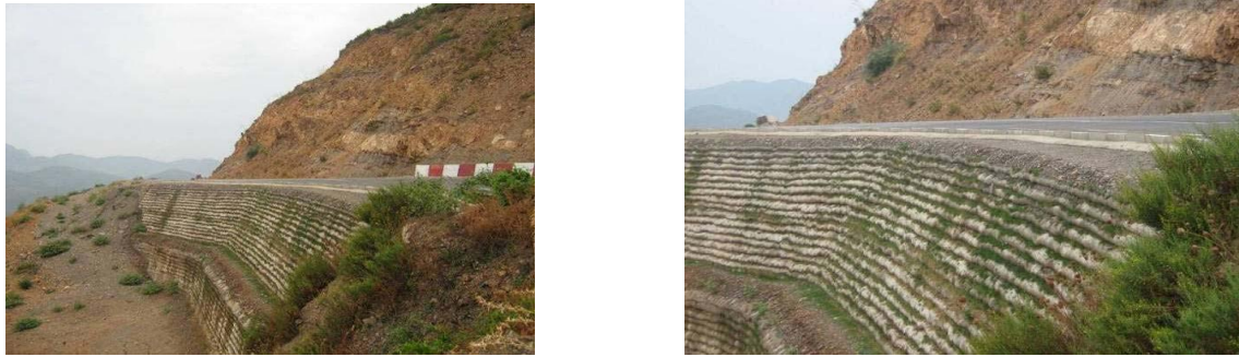
Figure 3.7: remblai avec la géosynthétique
