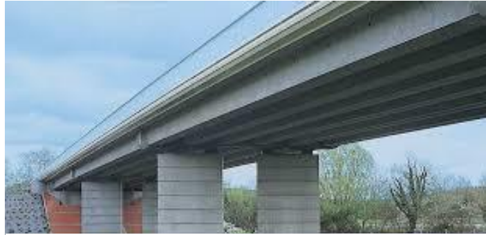
Figure 1.3 : pont en béton précontraint
