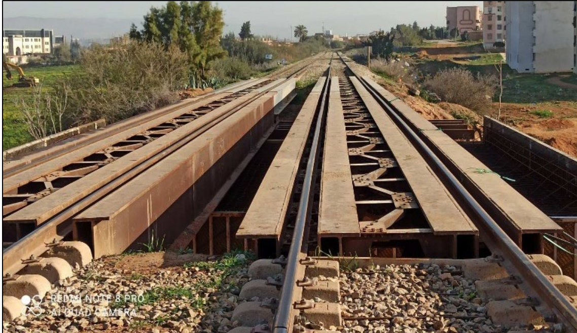
Figure 36: Photo au-dessus du tablier provisoire
