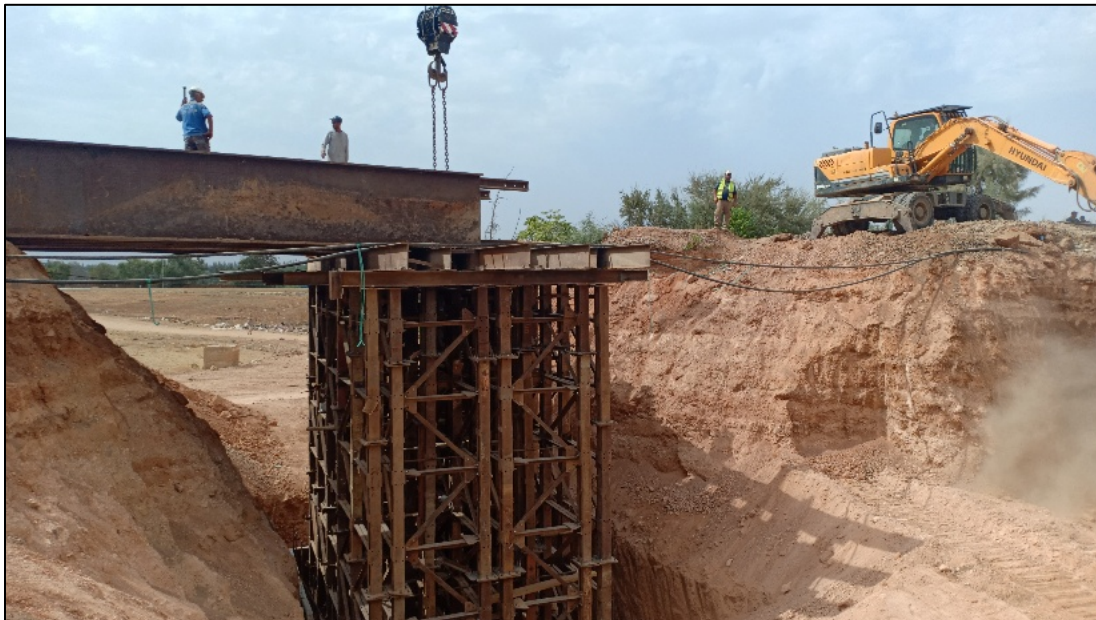
Figure 34: Photo réelle de l'étape de déplacement du tablier de 22m
