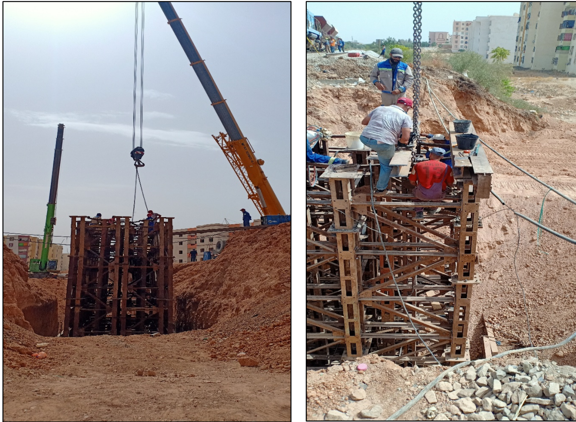
Figure 32: Photos réelles de la mise en place de la palée métallique
