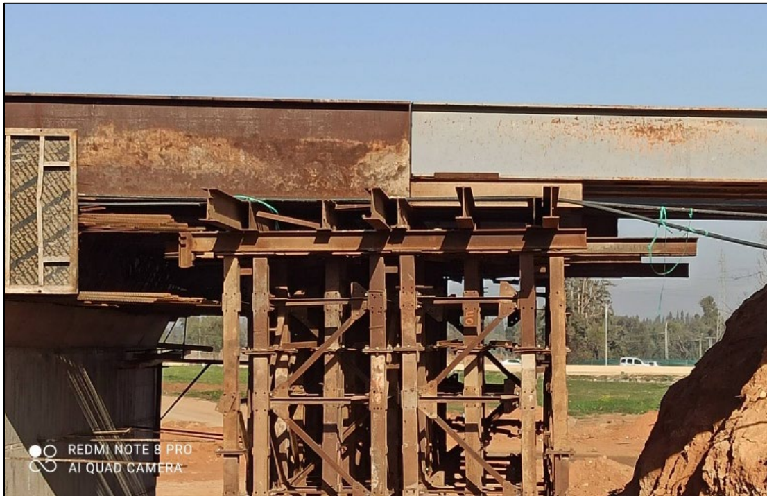
Figure 35: Photo réelle de la pose du tablier de 17m
