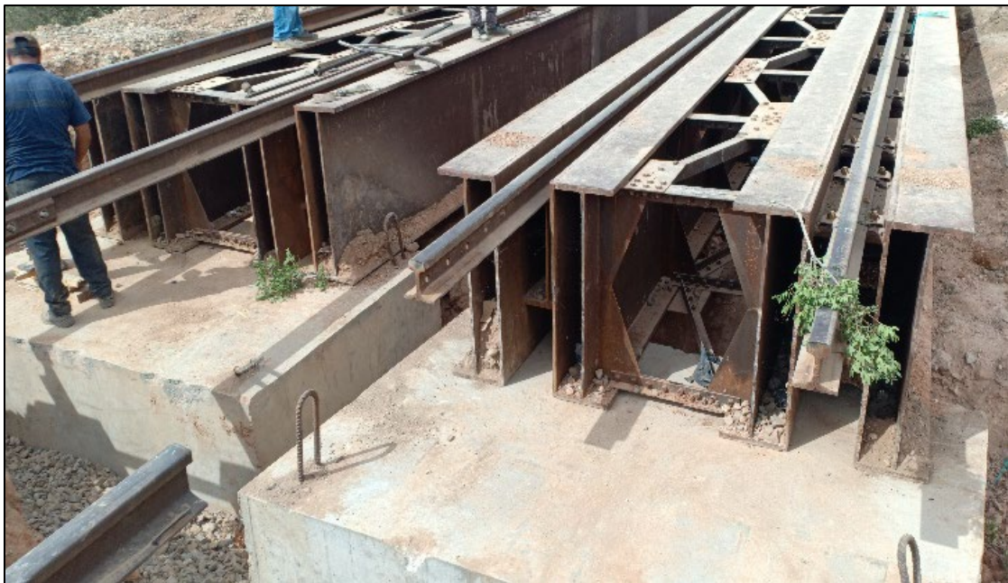
Figure 29: Pose des deux tabliers auxiliaires
