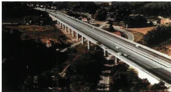
Figure XIII.1 : Ponts à poutres précontraintes par post-tension.
