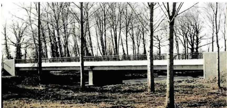
Figure XIII.4 : Vue générale d'un ouvrage PRAD.
