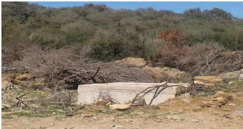
Figure XV.6: regard en béton.
