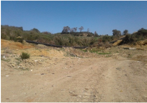
Figure XV.4 : la conduite de gaz.
