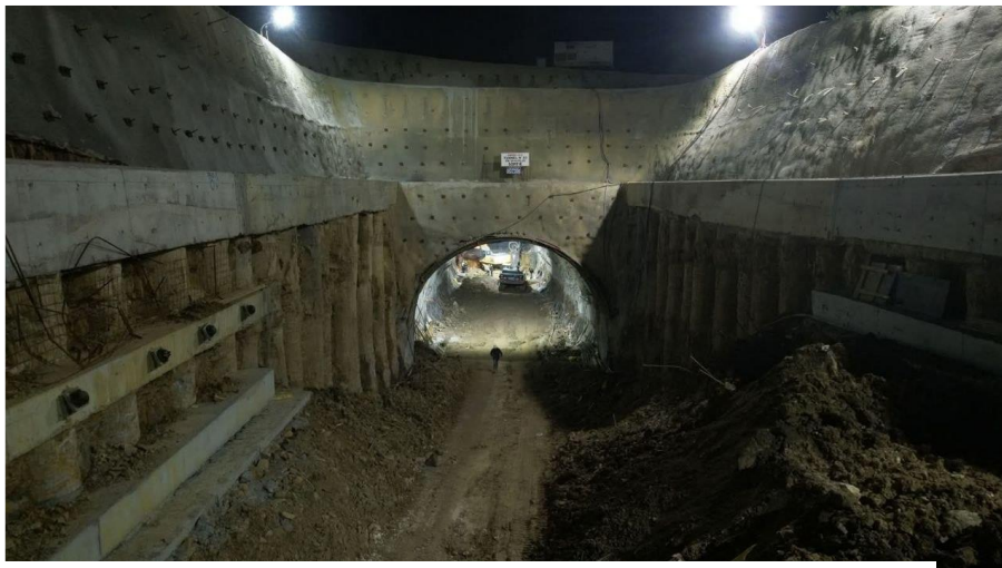
Figure II.5 Portail de tunnel ferroviaire de la LFME en cours de construction (Vue aérienne - commune de Chihani, wilaya d'El-Tarf) Source : ANESRIF / Ministère des Travaux Publics
