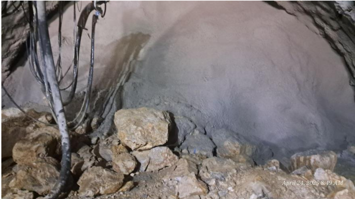
Figure I.17 Stabilisation du front de taille par application de béton projeté
