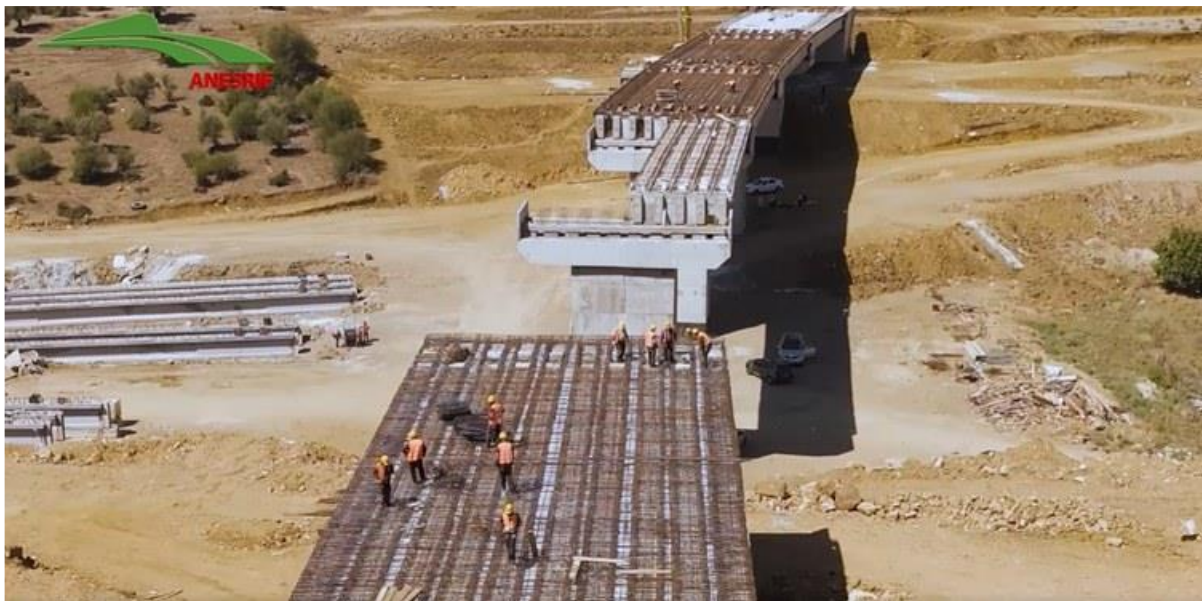
Figure II.4 Construction du tablier d'un pont ferroviaire sur le tronçon Annaba–Bouchegouf Pose des armatures et coulage du béton (tronçon montagneux, Guelma / El-Tarf) Source : ANESRIF / Ministère des Travaux Publics (Canal Algérie)
