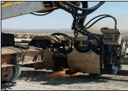
Figure I-8 : Soudure électrique
