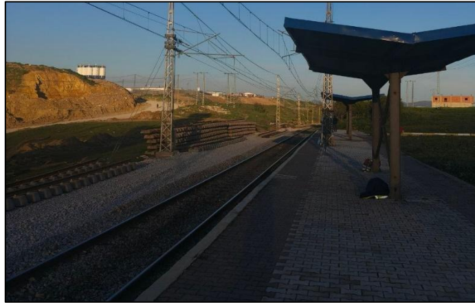
Figure III-2 : Ligne ferroviaire existante
