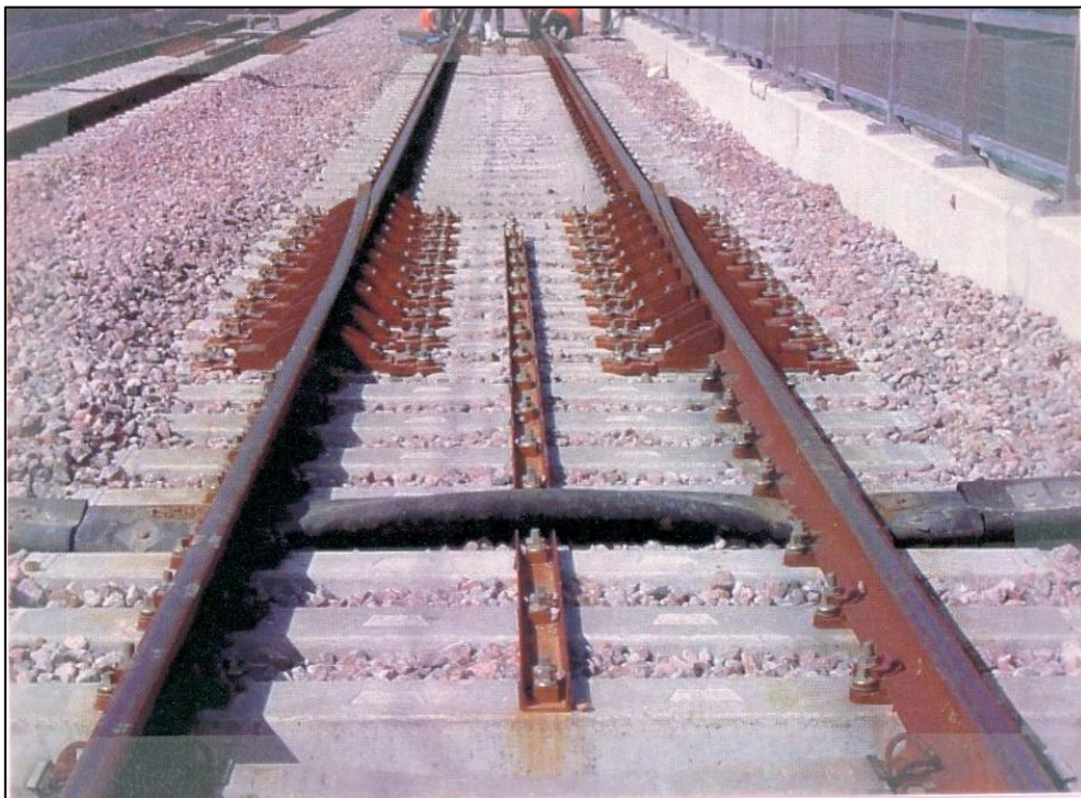
Figure IX-3 : Dispositif d'un appareil de dilatation
