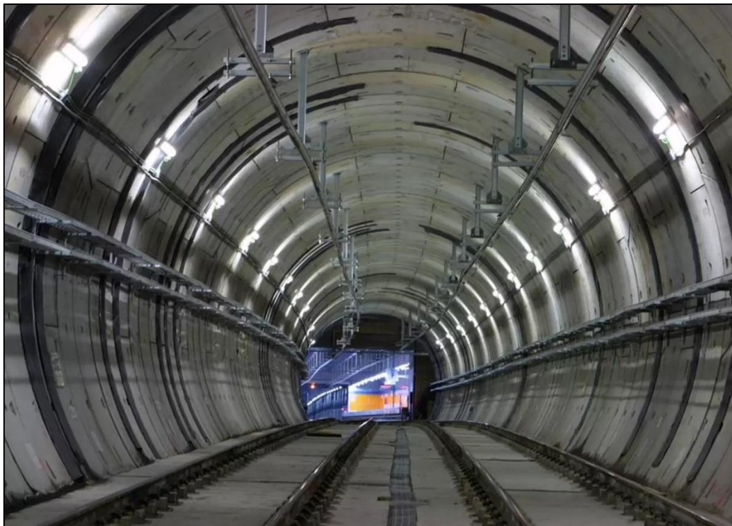
Figure IX-7 : Caténaire suspendu
