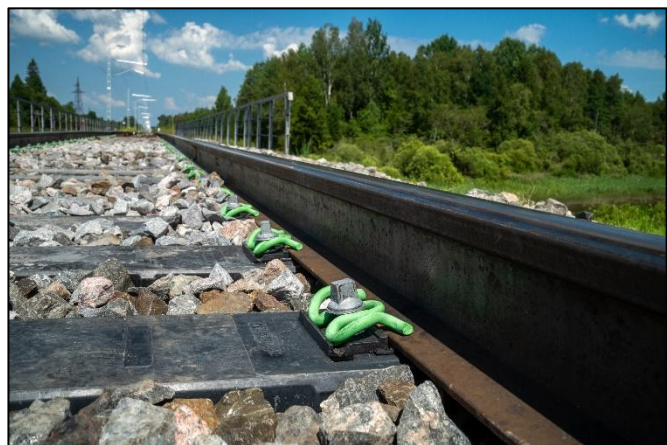
Figure I-5 : système d'attache VOSSLOH
