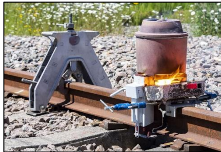
Figure I-9 : Soudure aluminothermique
