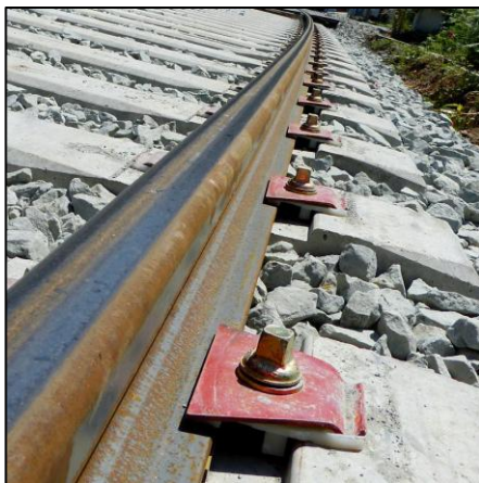
Figure I-6 : Système d'attache NABLA
