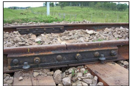
Figure I-10 : Les joints par éclissage
