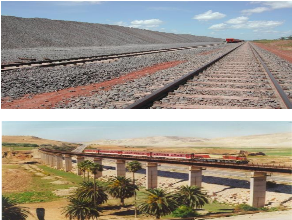
Figure. 01 , Les infrastructures de transport ferroviaire
