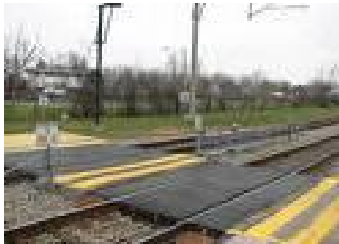
Figure.03. Les traversées de voies.
