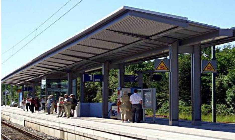
Figure.02. Auvents et abris.
