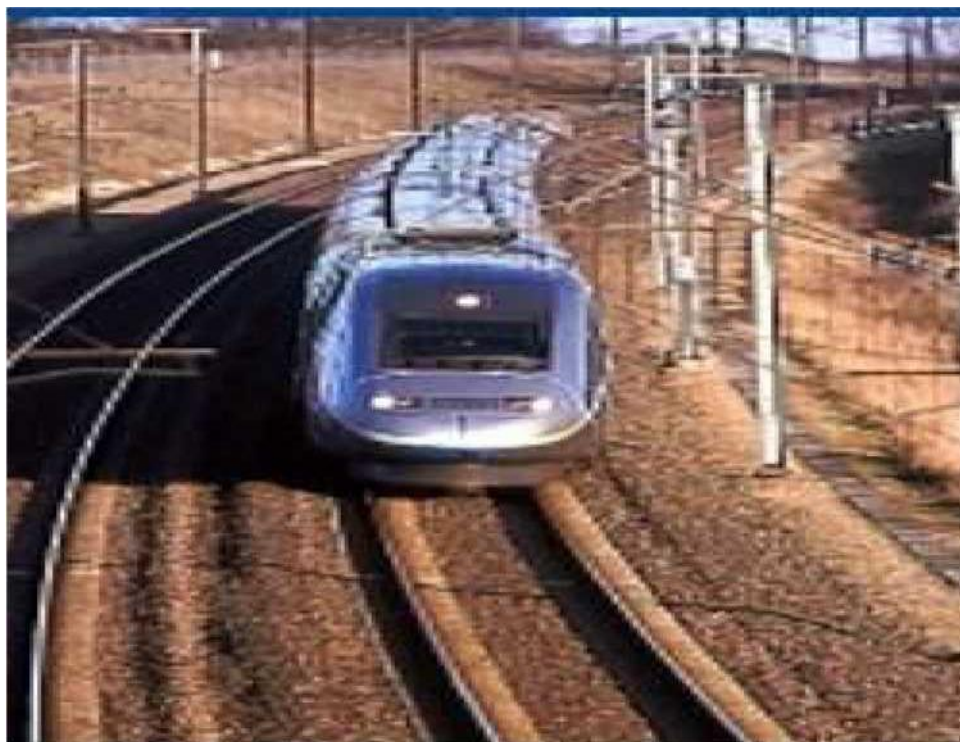
Tronçon à voie double électrifiée (Thenia - Boudouaou)
