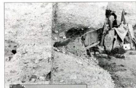
Photo 2. Remplissage en grosses pierres du pisé à Honaïne.
