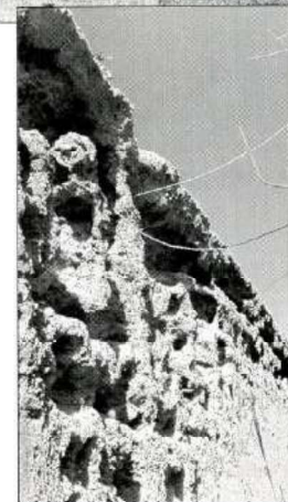
Photo 2. Remplissage en grosses pierres du pisé à Honaïne.
