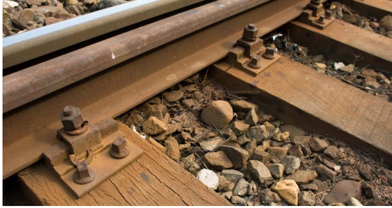
Figure III.3.Travers en bois
