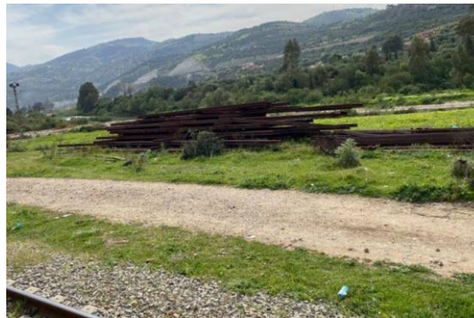
Figure XIII.5. Dépot de rails de l'ancienne voie au niveau de la gare de Takrietz au PK 40+100
