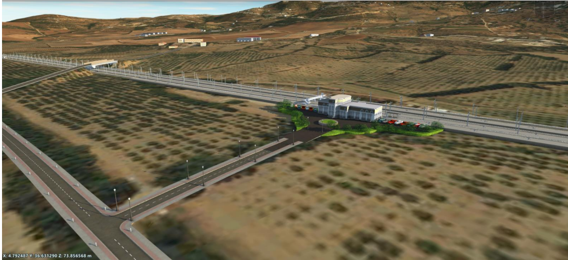
Figure XIV.12. Entrée du parking de la gare El Maten et sa liaison avec la voie routière
