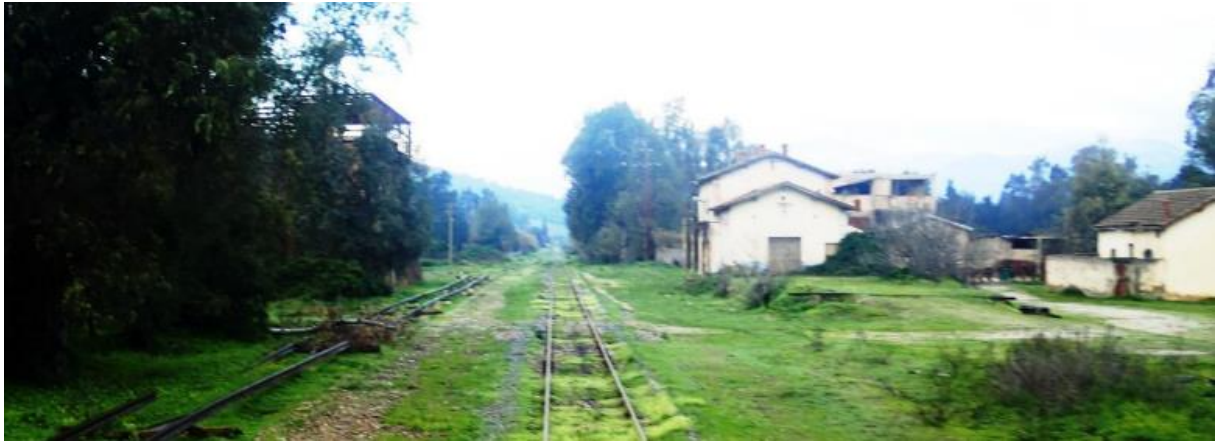
Figure XIV.7.Photo réelle de la gare El Maten.
