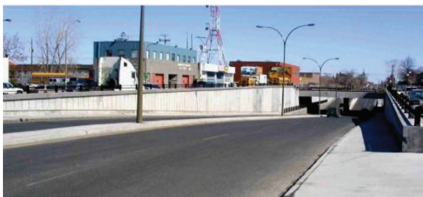
Figure V.8 : Aspect final des réparations [121]
