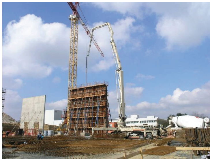
Figure V.13 : A la pompe en tête de coffrage avec tube plongeur
