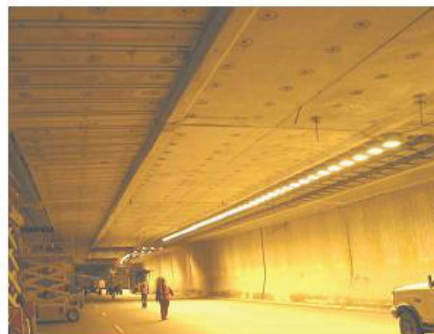
Figure V.10 : Aspect finale des réparations [123]
