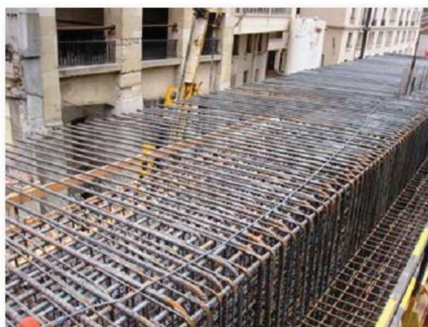
Figure V.1 : Elément de structure fortement armés ou l'utilisation des BAP est constitué la solution idéale
