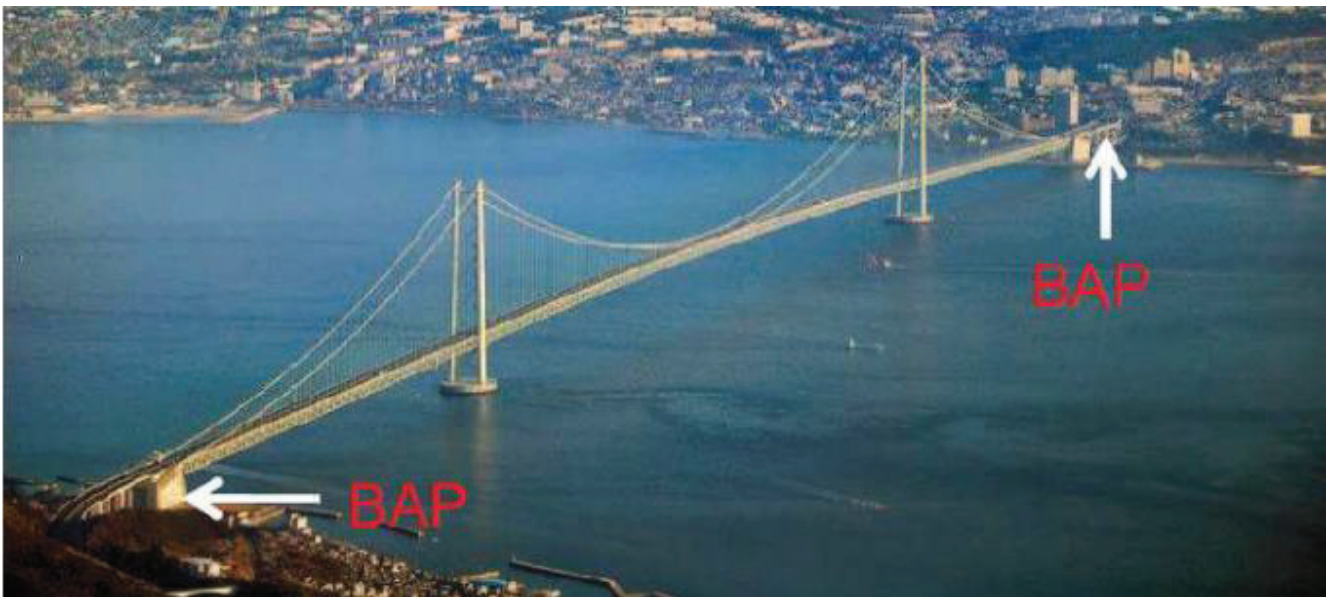
Figure I.1 : Le pont Akashi Kaikyo [4]
