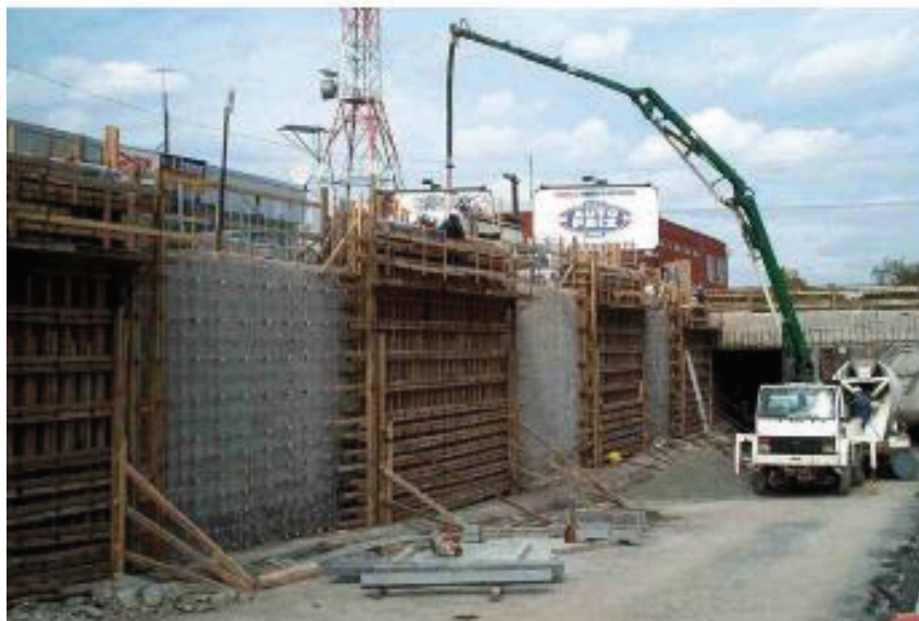
Figure V.7 : Mis en place du béton autoplaçant [121]
