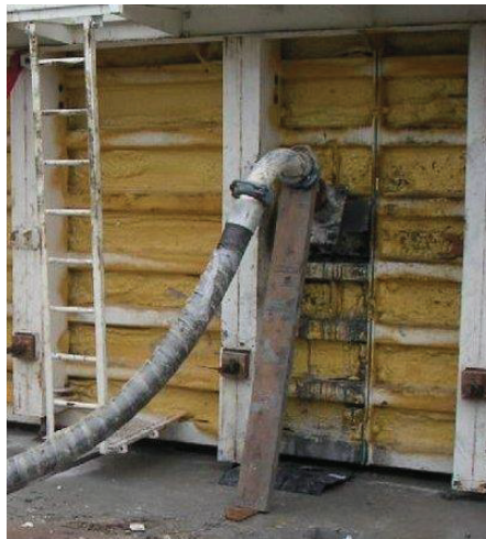
Figure V.12 : A la pompe avec injection en pied de coffrage
