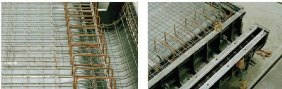
Figure V.5 : Application du BAP a la préfabrication (a) (rapporté par [46])
