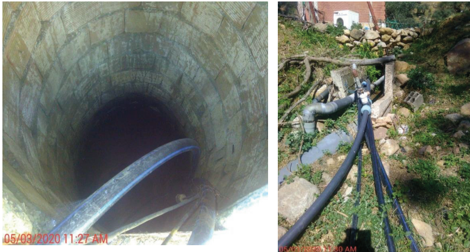
Figure IV.9 Puits drainant au niveau de site d'étude à Tifra
