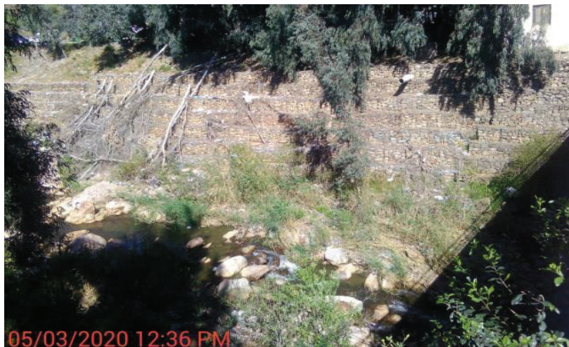
Figure IV.11 Mur en gabion à Tifra (Bejaia).
