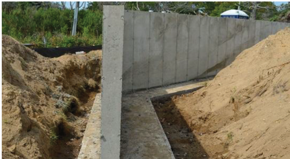
Figure VIII.8.Exemple d'un mur de soutènement
