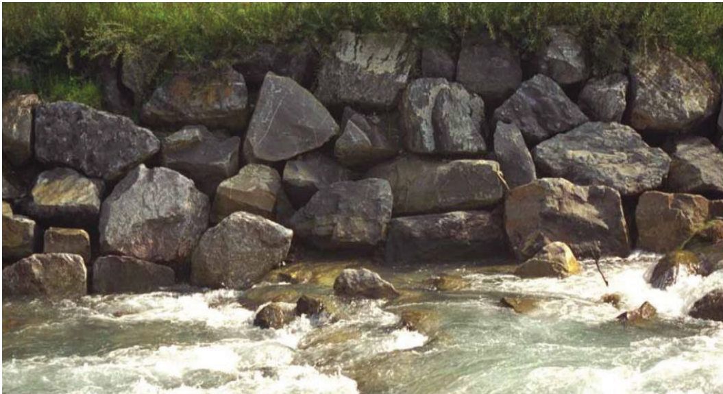
Figure VIII.10. Exemple d'un enrochement
