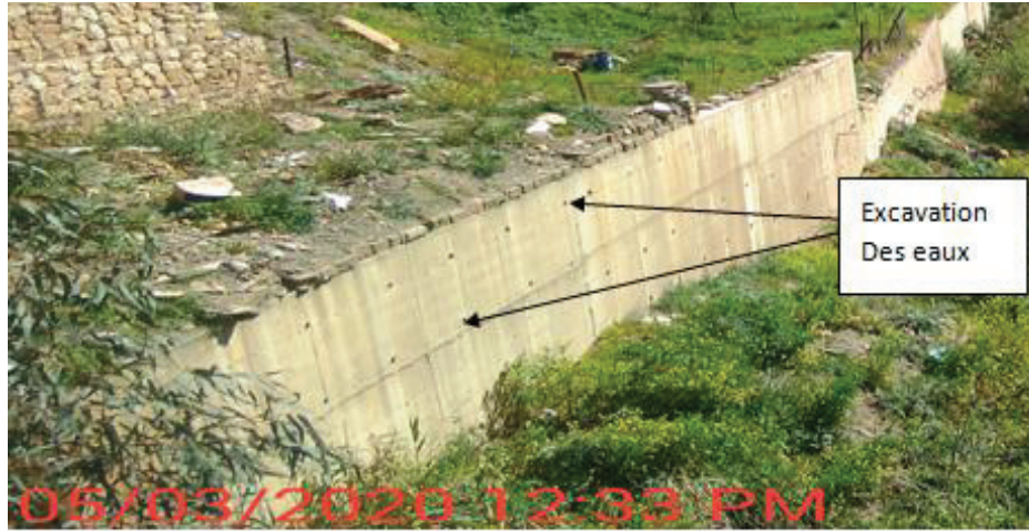
Figure IV .18 Mur de soutènement en béton à Tifra (Bejaia).
