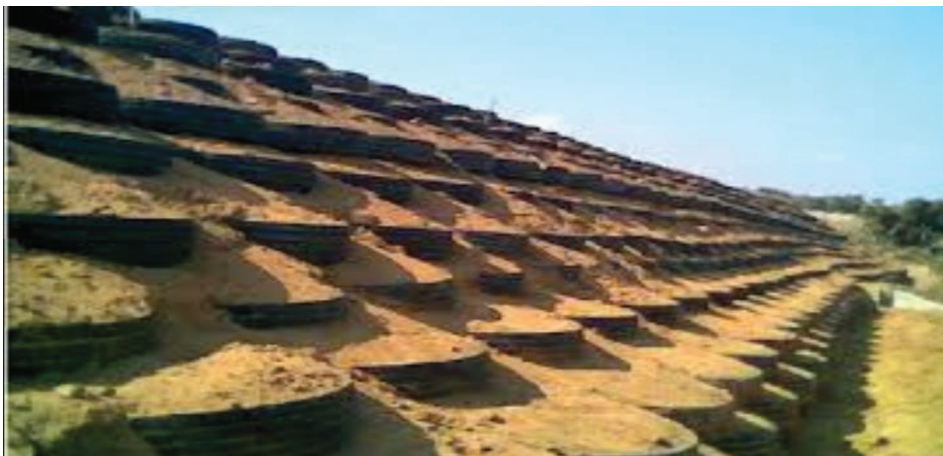
Figure IV.17 chantier expérimental Pneusol à Bou-Smail [S12]
