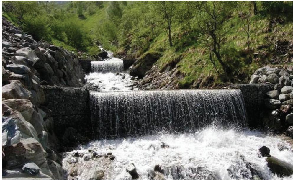
Figure VIII.12. Exemple d'un seuil en gabion.
