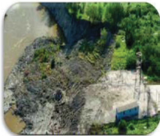
a. Glissement rotationnel multiple en bordure de la rivière Chicoutimi Complexe [S9]
