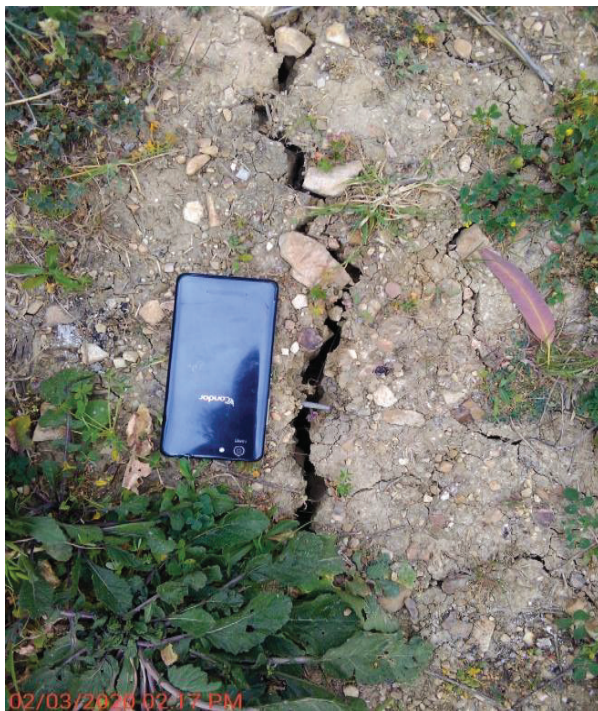
Figure VI.6. Fissure dans le sol.
