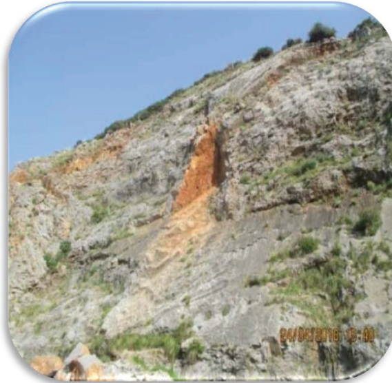
Figure I.2. Exemple d'éboulement en amont de l'ancienne RN°9, Aokas [S13]
