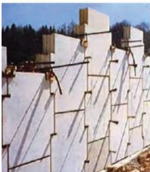
Figure IV.13 Vue d'un mur de soutènement en terre armée [S13]
