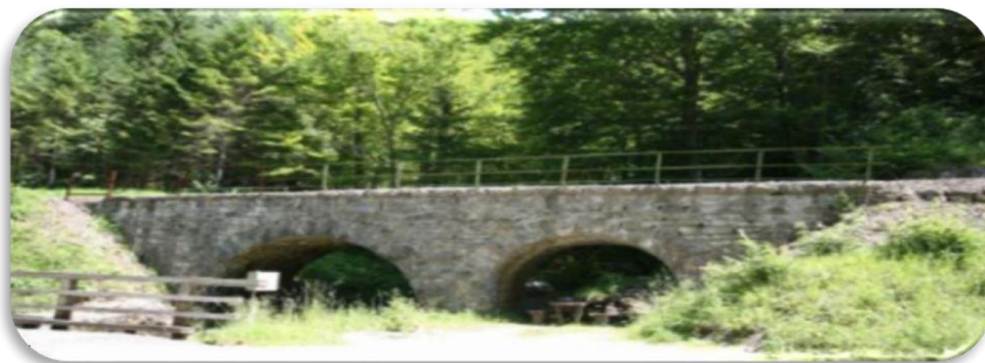
Figure I. 2. Pont en maçonnerie.
