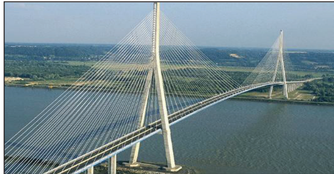
Figure I.6 Pont à haubans
