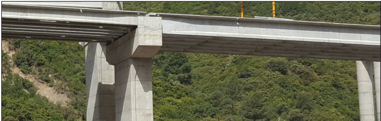
Figure I.4 Pont poutre en béton précontraint
