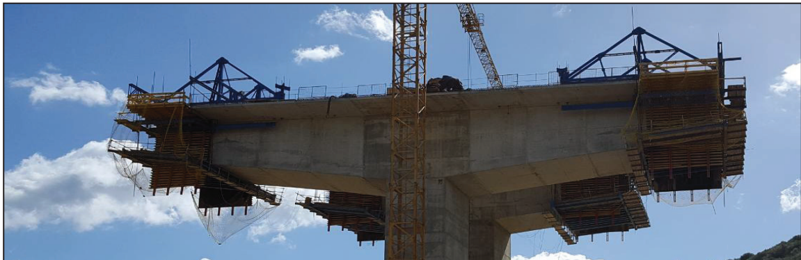
Figure II.1 Voussoir coulé en place par l'équipage mobile
