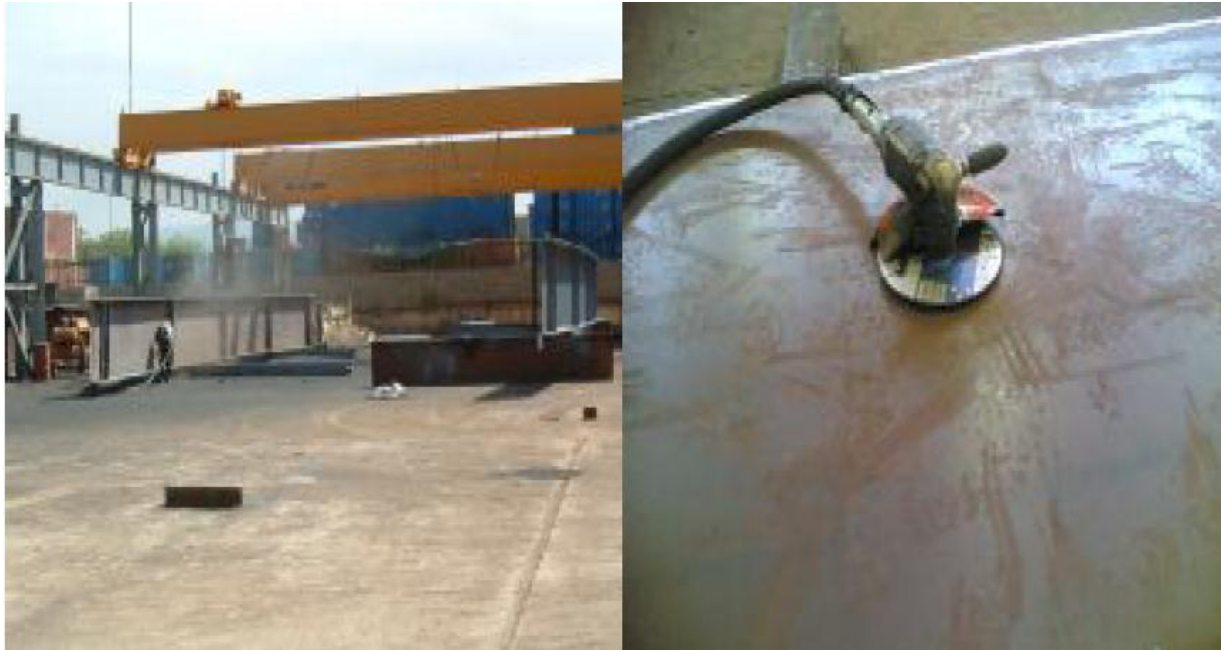
fig.VI-47 Peinture anticorrosion des poutres (usine de Rouïba).
