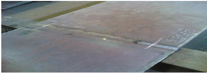
fig.VI-44 Soudure automatique des PRS en atelier.
