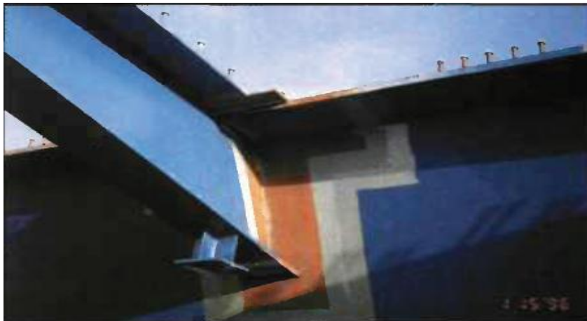
fig.VI-31 Assemblage soudé entretoise-âme.
