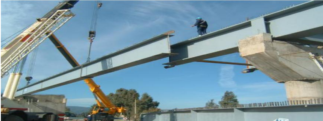
fig.VI-46 Levage des poutres par grue.
