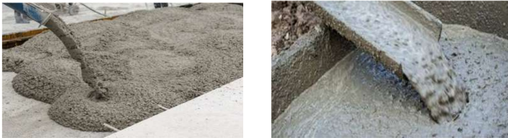
Figure 1 - Mélange du béton
