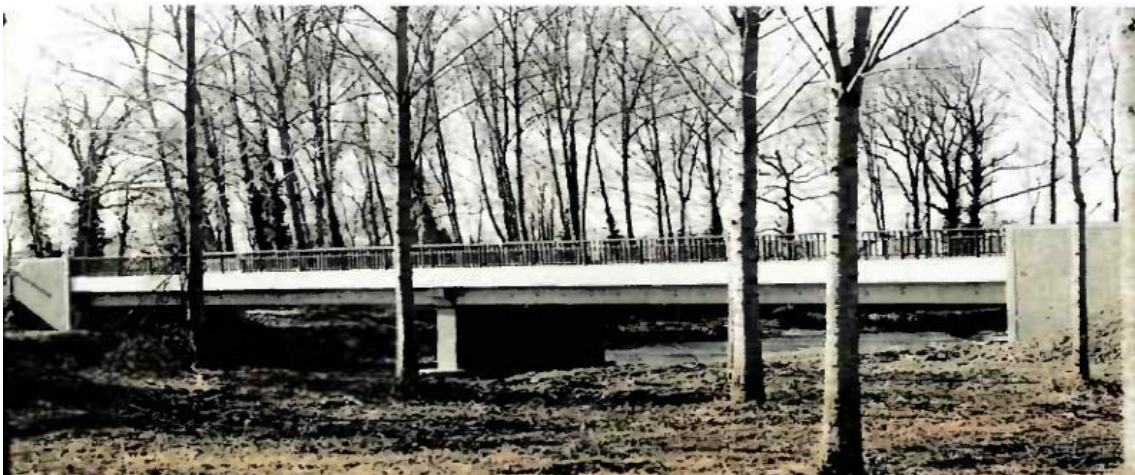
Figure IX.4 : Vue générale d'un ouvrage PRAD.
