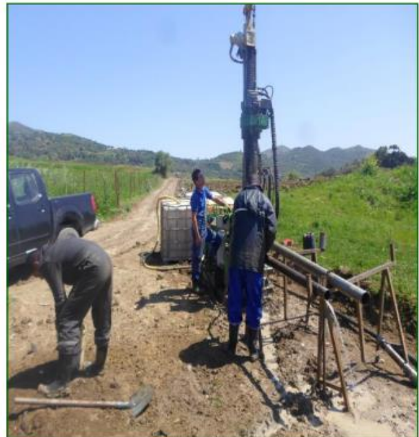
Photos (02) et (03) : Réalisation des Sondages carottés sur le site du projet SC-1 et SC-2
