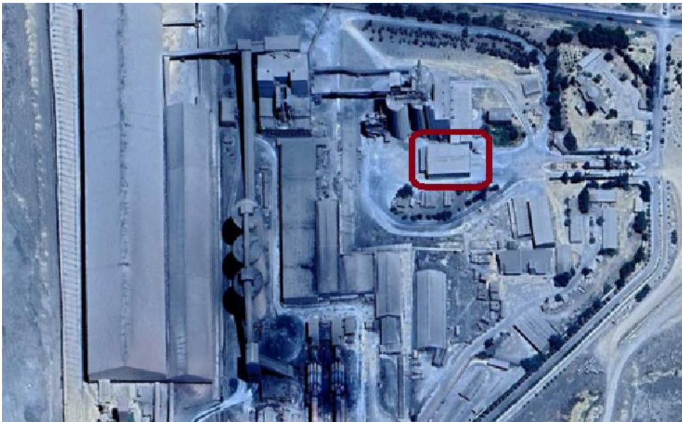
Figure I-3 : localisation du hangar
