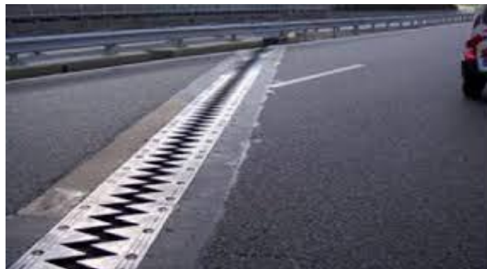
Figure VI.3 : Joint de chaussée.
