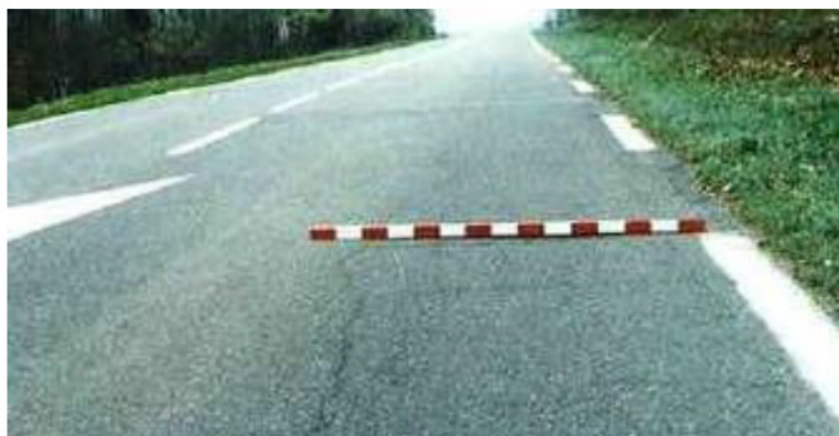
Figure 13: Exemple de fissuration longitudinale non spécifique aux bandes de
