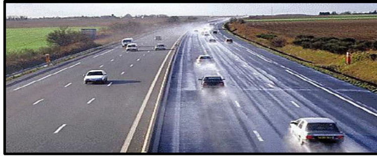
Figure 7: Chaussées d'autoroute avec et sans enrobé drainant
