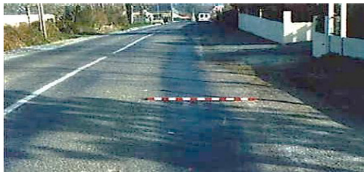
Figure 16: Glaçage de surface de chaussée
