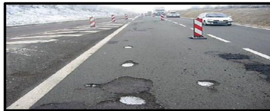
Figure 20: Exemple de nid de poule
