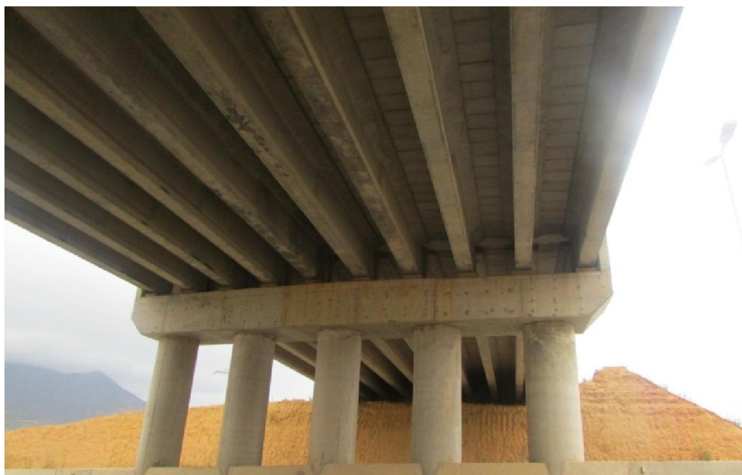
Figure 2. 5 : Vue de dessous de l'ouvrage au PK. 40+300.
