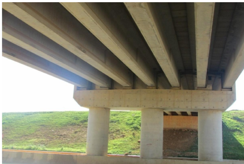
Figure 3. 17 : Vue de dessous de l'ouvrage au PK. 49+000.
