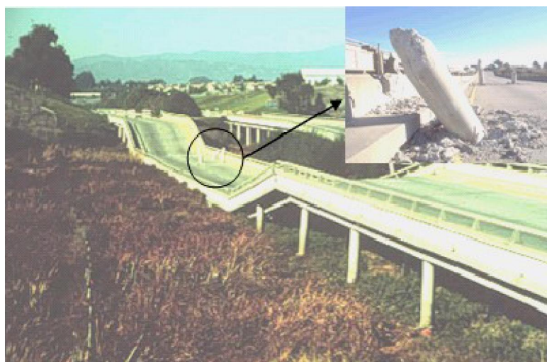
Figure 1.32 : Effondrement du pont route 1, Struve Slough, Watson Ville.
