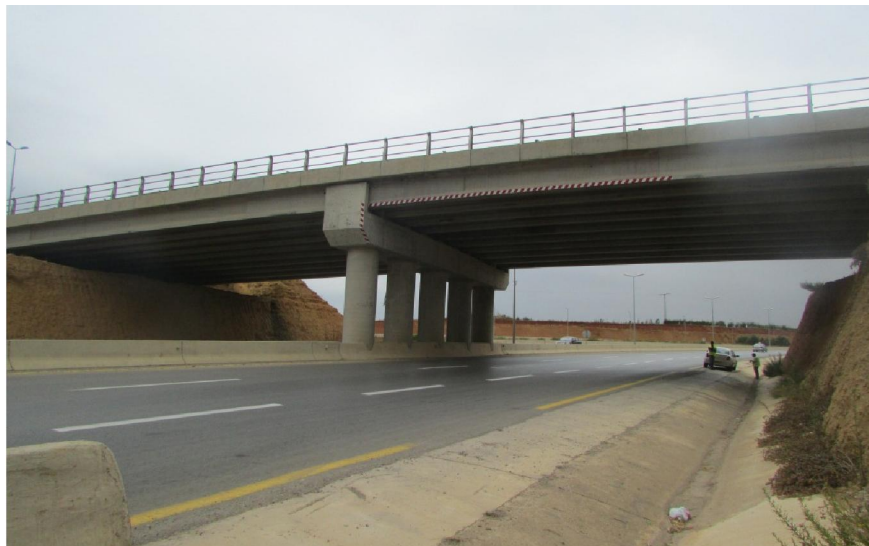
Figure 2. 4 : Vue en élévation de l'ouvrage au PK. 40+300.
