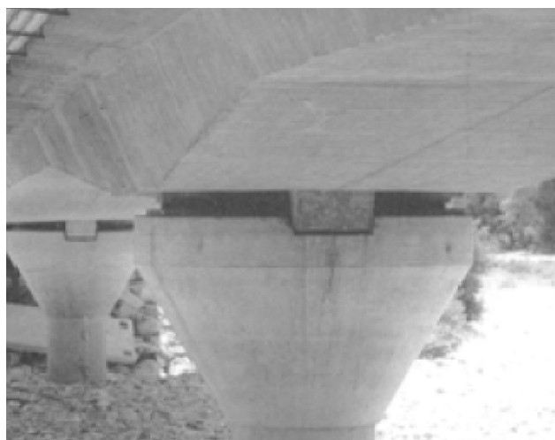
Figure 1. 17 : Exemple de butées latérales.
