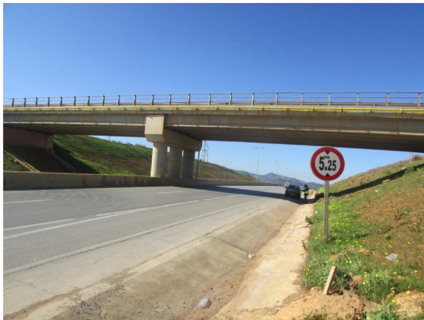
Figure 2. 7 : Vue en élévation de l'ouvrage au PK. 49+000.
