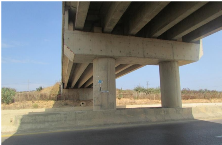
Figure 3. 2 : Vue de dessous de l'ouvrage au PK. 21+400
