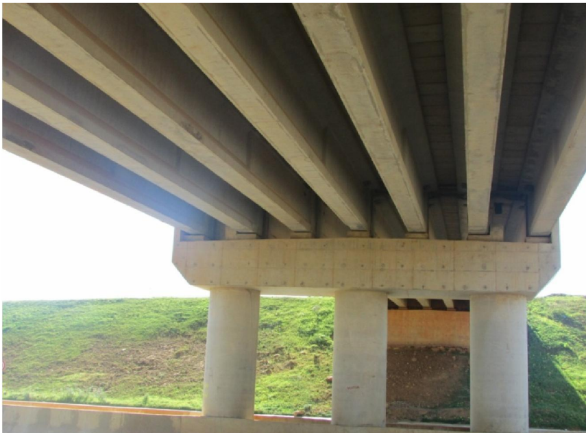
Figure 2. 8 : Vue de dessous de l'ouvrage au PK. 49+000.
