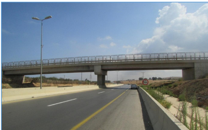
Figure 2. 2 : Vue en élévation de l'ouvrage au PK. 21+400.
