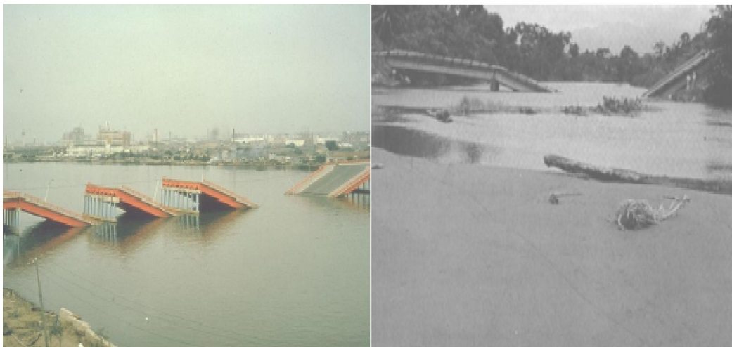
Figure 1. 31 : Exemple d'effondrements liés à la liquéfaction du sol porteur suite aux séismes de Niigata au Japon en 1964 et de Costa Rica en 1990.
