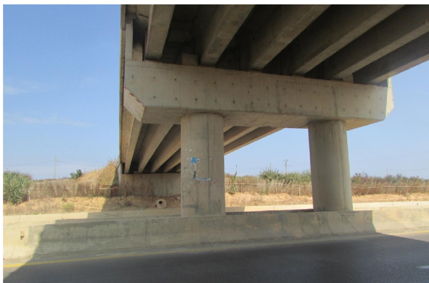
Figure 2. 3 : Vue de dessous de l'ouvrage au PK. 21+400.
