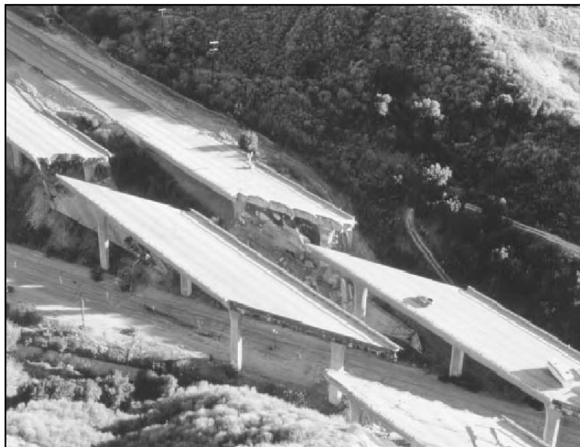
Figure 1. 5 : La ruine du Gavin Canyon Undercrossing en 1994 durant le séisme de Northridge.
