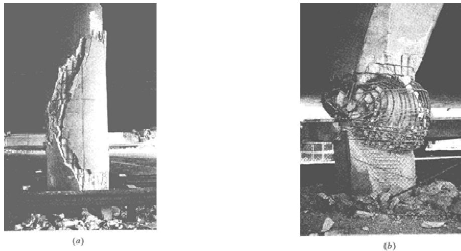
Figure 1. 11 : Les défaillances possibles des piles.
