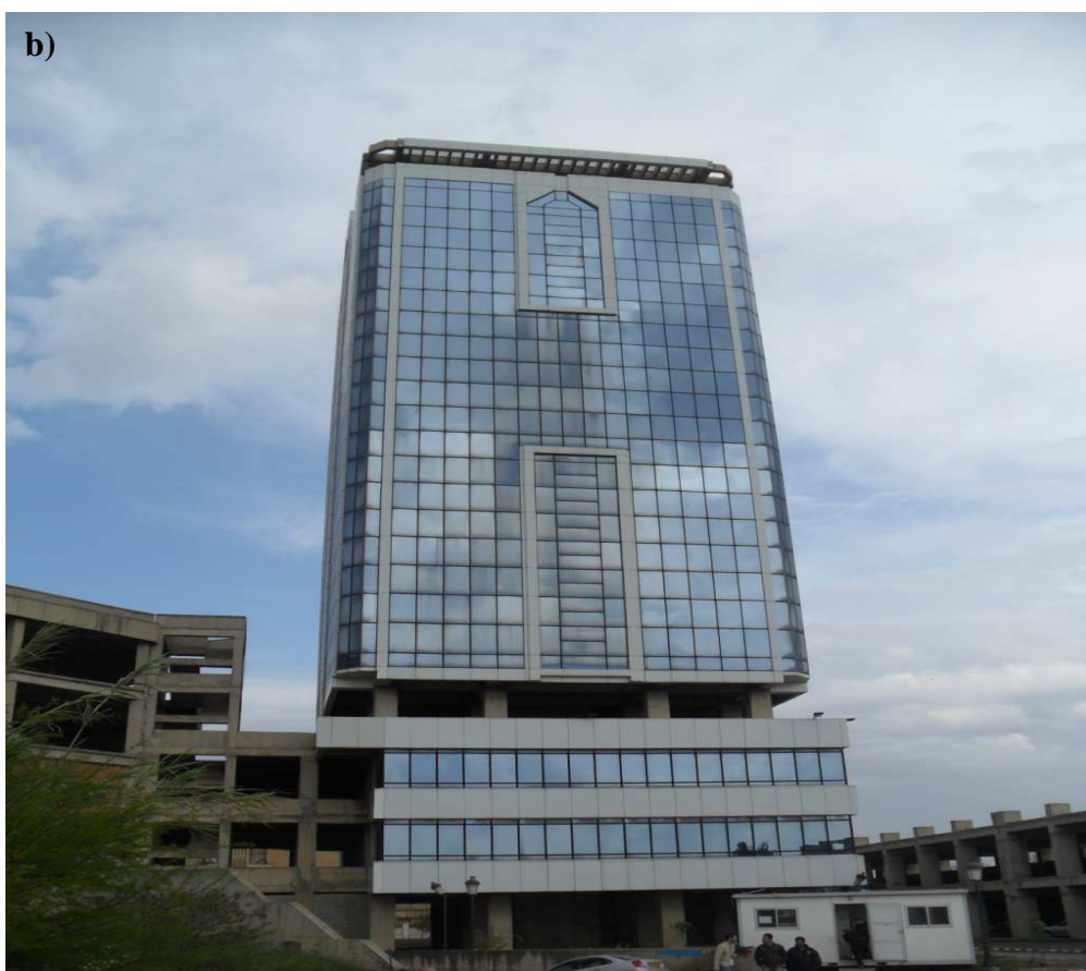
Figure III.2 : Vue générale des deux tours. a) la tour du ministère du commerce, b) la tour inoccupé.
