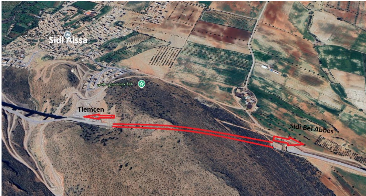
Figure II.2: image satellitaire du tunnel de PK 125+838 et 126+482
