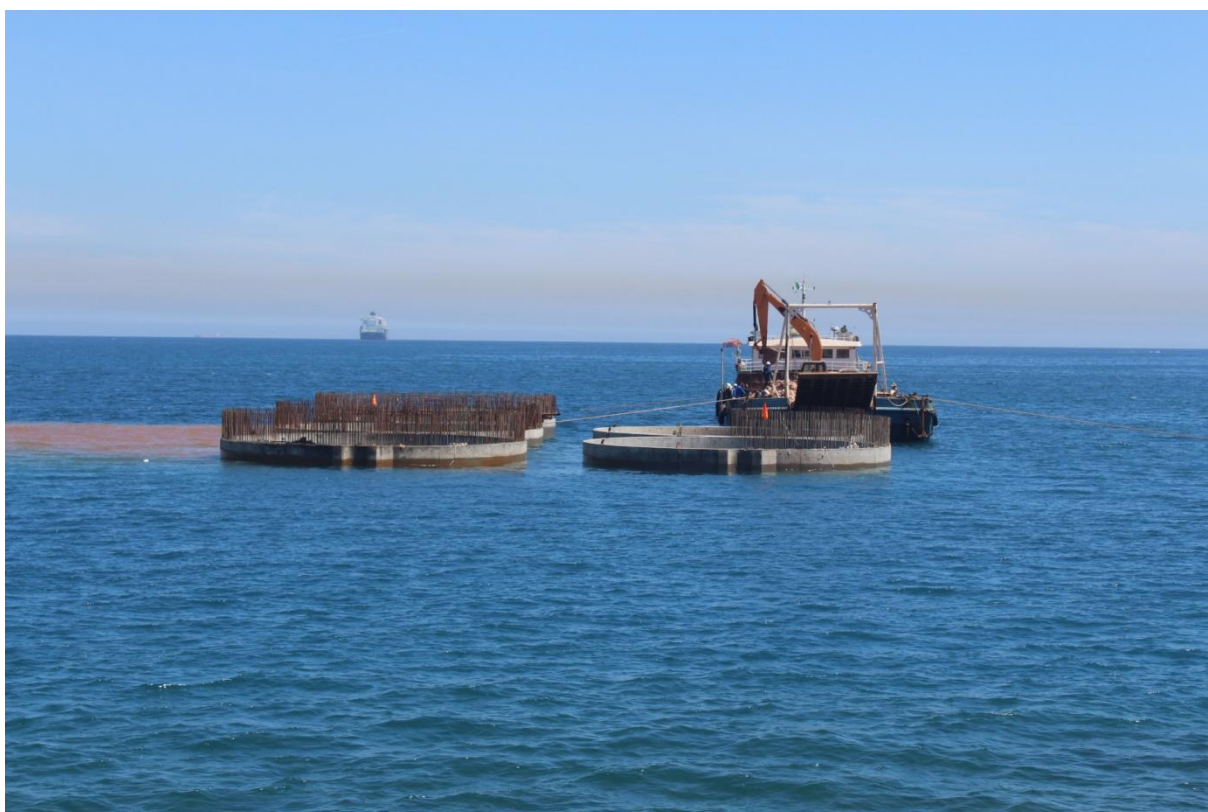
Photo 14 : Remplissage des caissons par les enrochements
