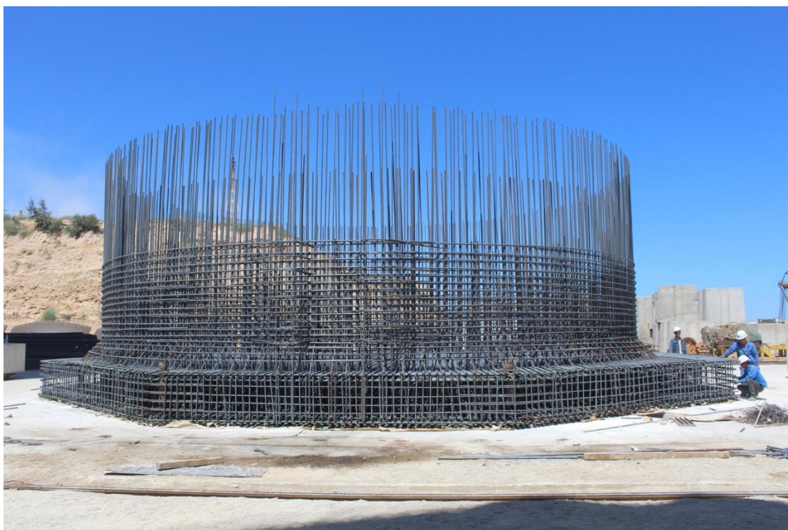
Photo 7 : Ferrailage du radier
