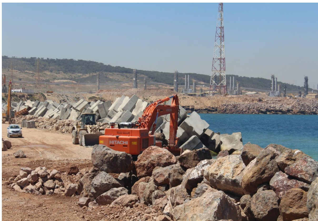
Photo 3 : Mise en place des enrochements naturels dans le coté Ouest
