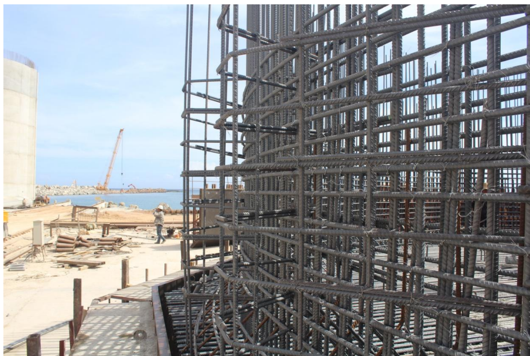
Photo 8 : Ferrailage de la première élévation du caisson
