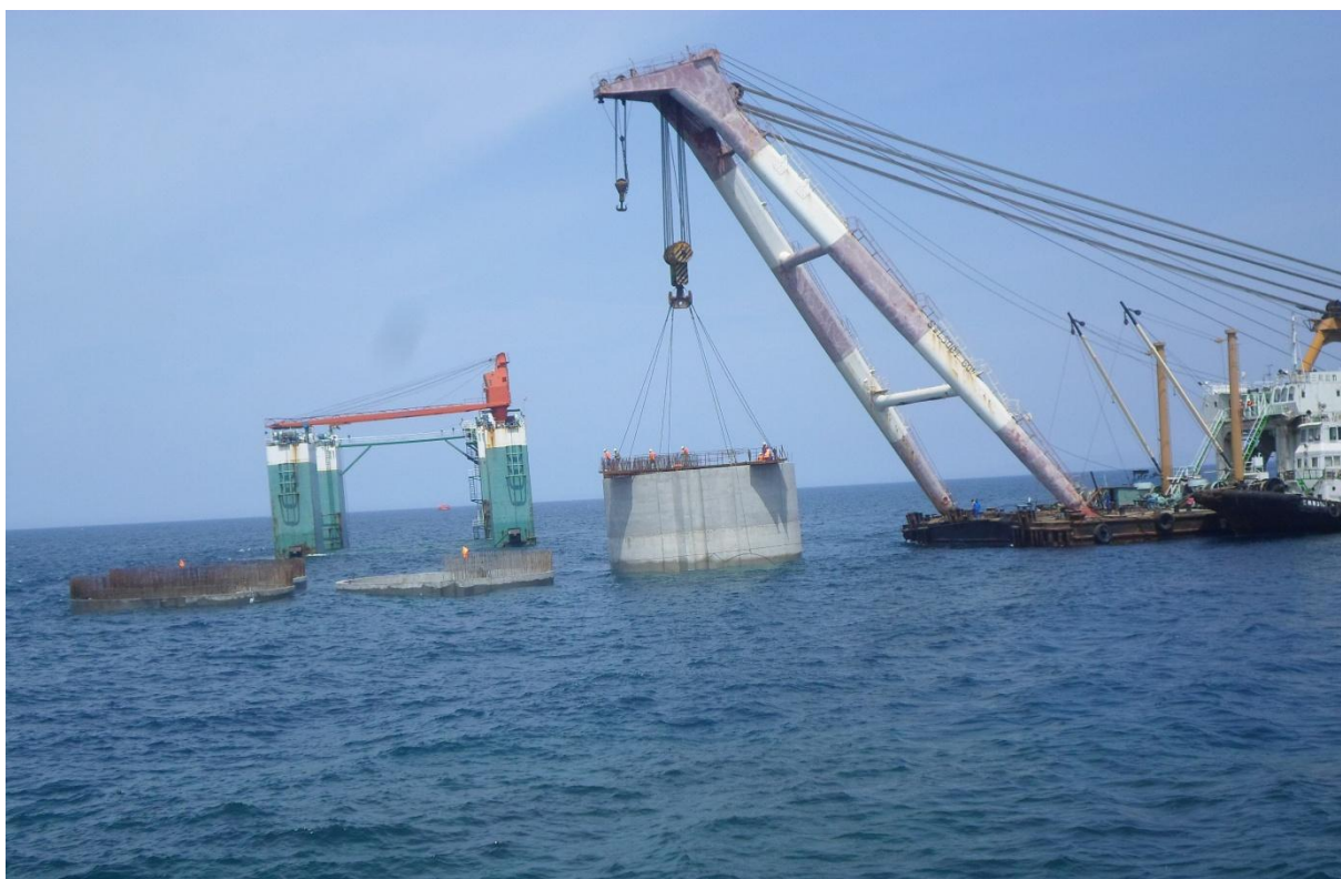
Photos 13 : Mise en place du caisson sous l'eau
