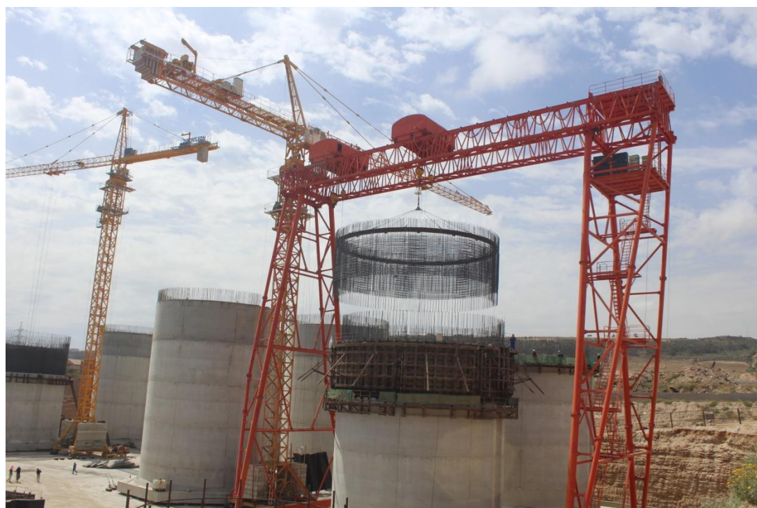
Photo 10 : Mise en place du ferrailage de la cinquième élévation du caisson
