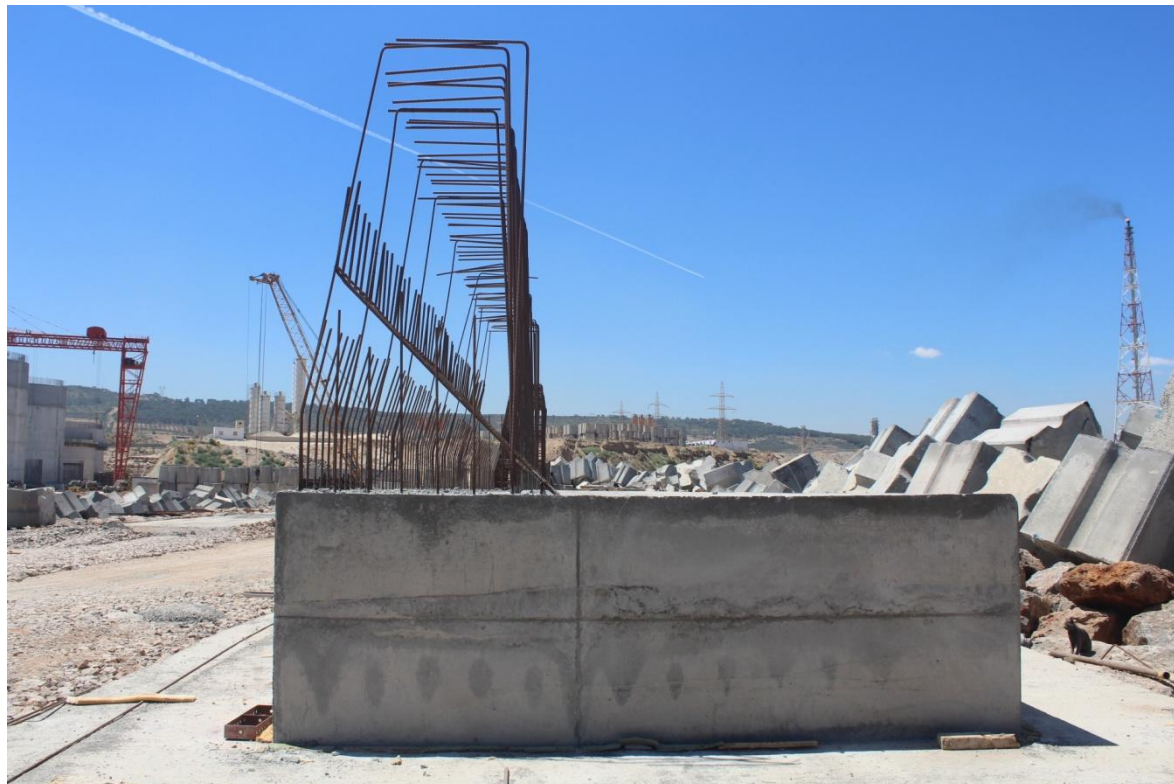
Photo 6 : Ferrailage du couronnement
