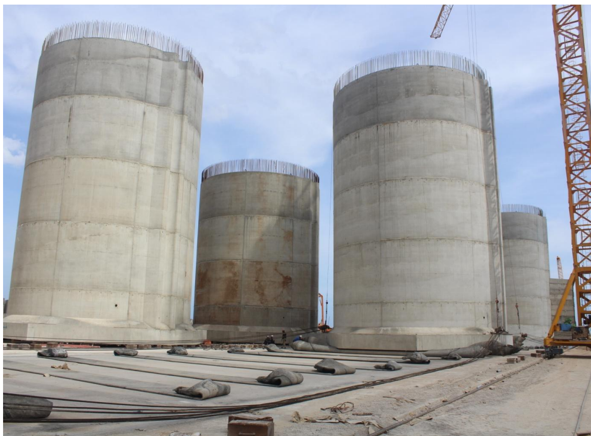
Photo 11 : Mise en place des caissons dans la zone de stockage
