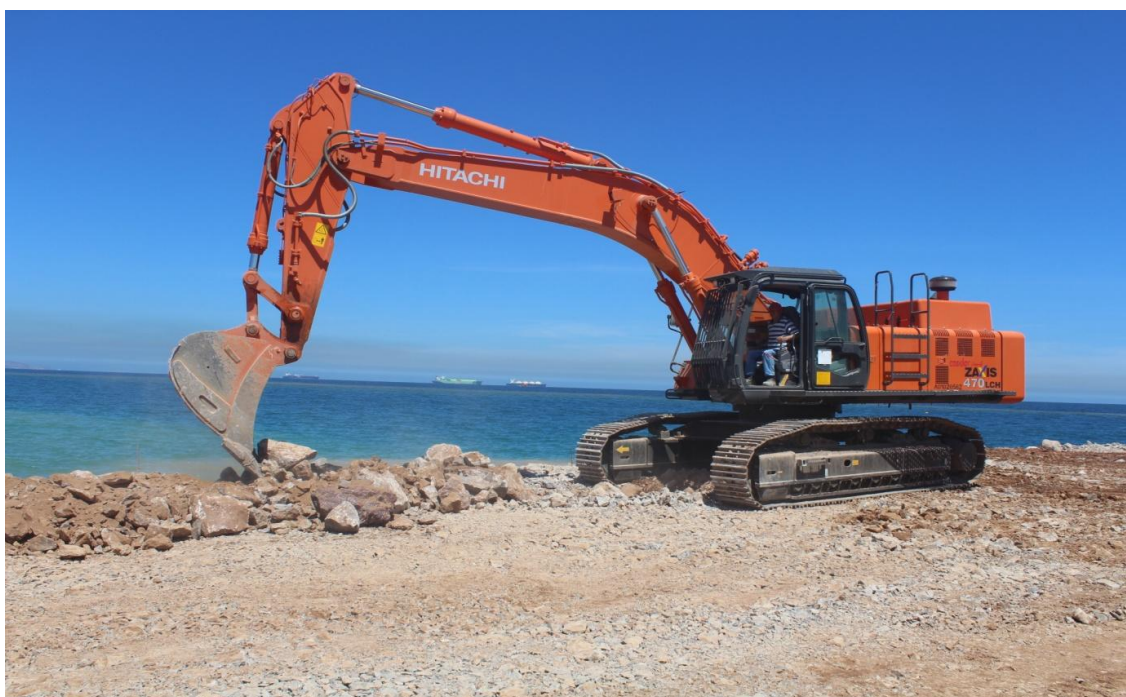
Photo 2 : Mise en place des enrochements naturels dans le côté Ouest
