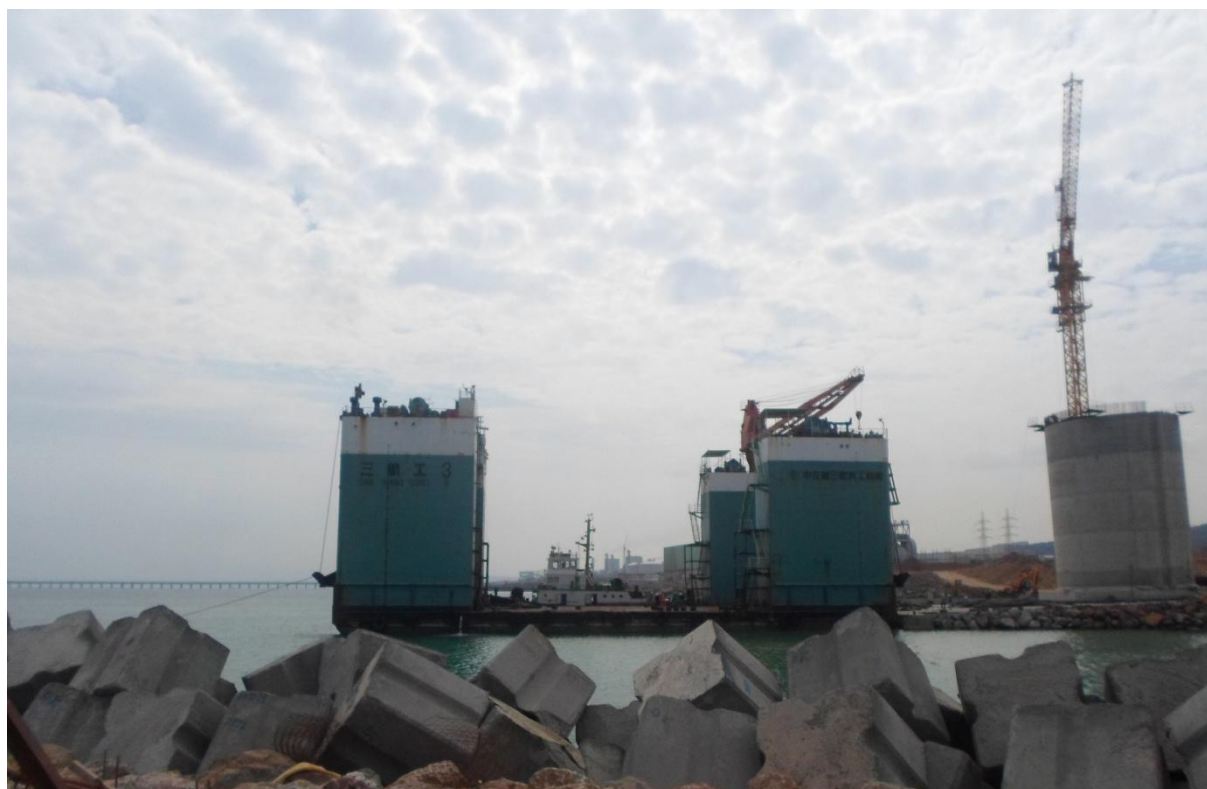
Photo 12 : Transport du caisson par le dock flottant
