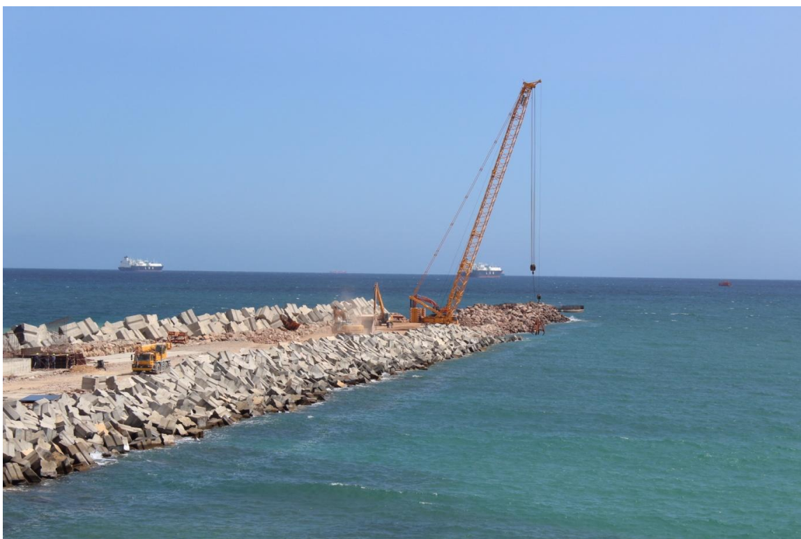
Photo 5 : Mise en place des enrochements naturels dans le coté Est
