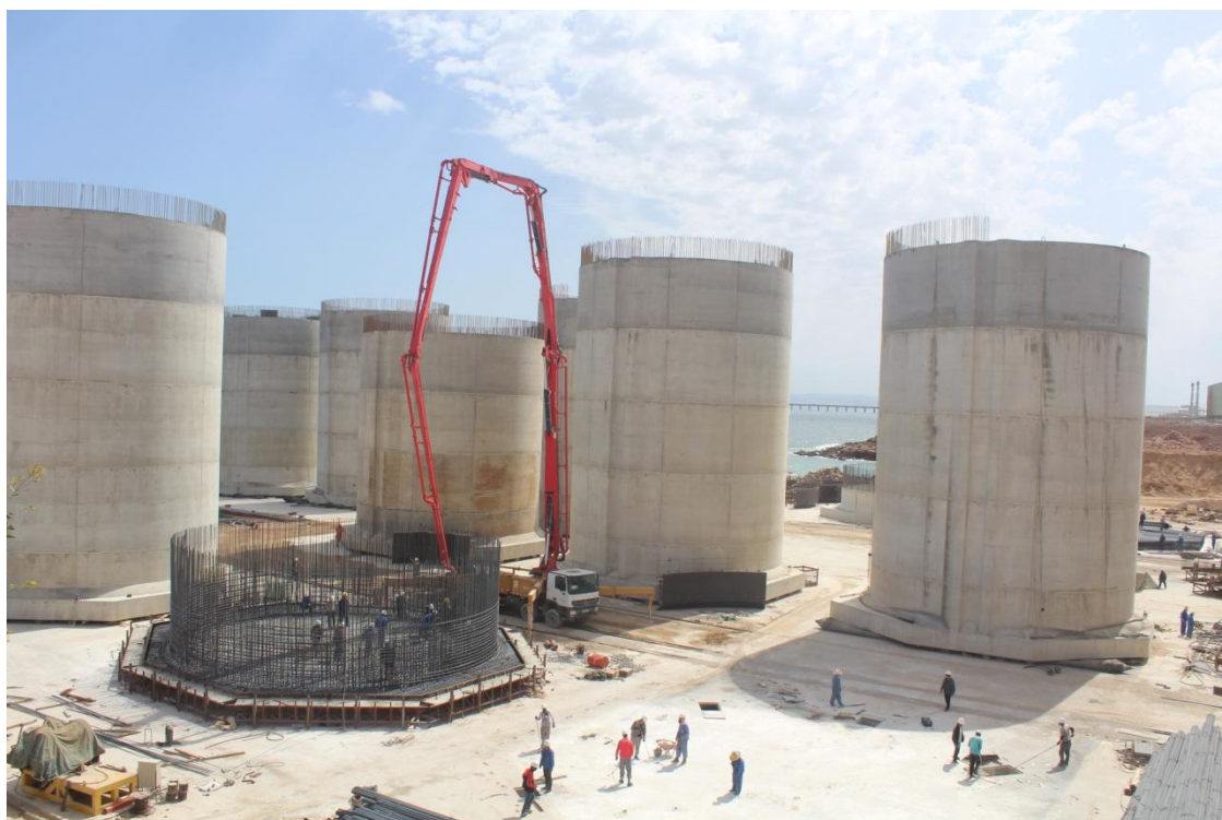
Photos 9 : Mise en place des caissons dans la zone de stockage
