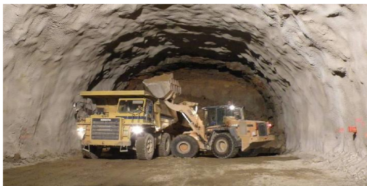
Figure X. 2. Travaux de déblai dans l'intérieur du tunnel
