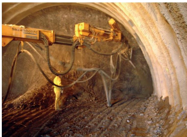
Figure X.3. Mise en place du béton projeté
