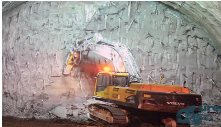
Figure V.10.Renforcement du front par des boulons en fibre de verre
