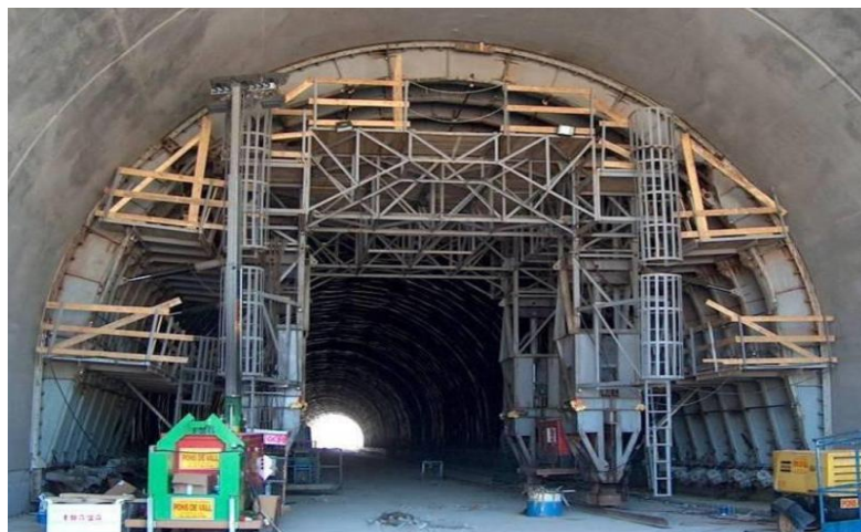
Figure.1.Chariot de coffrage
