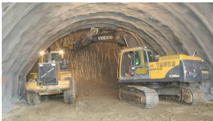
Figure X.1.Excavation avec rétro-excavatrice
