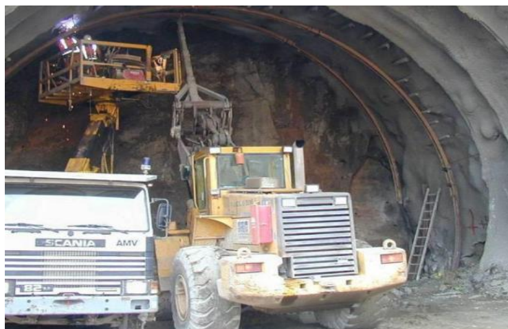
Figure X.4.Mise en place d'un cintre
