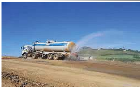
Figure XII.1. Arrosage des pistes de chantier.
