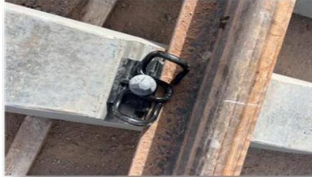
Figure II-10: Le système d'attache VOSSLOH
