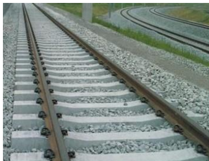
Figure II-7: Traverse en béton
