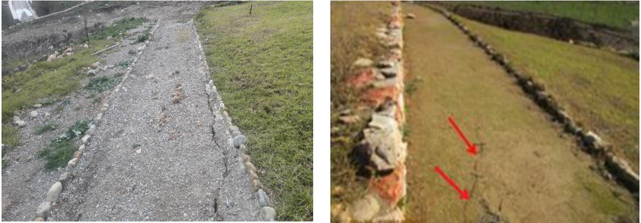
Figure III.7. Nouvelle génération des niches d'arrachements et des fissures de traction
