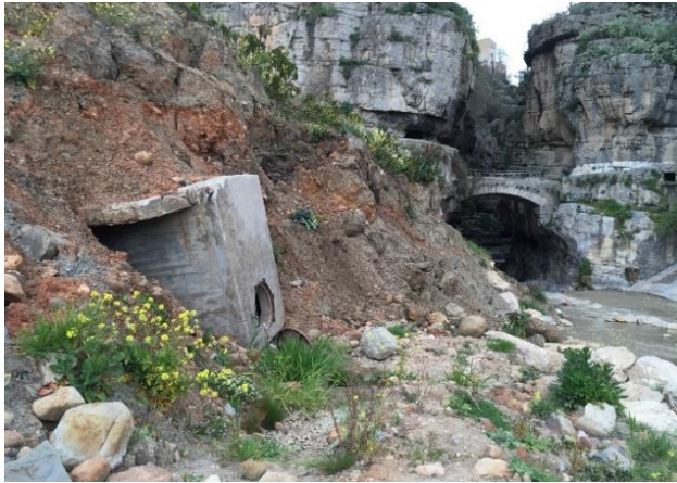
Figure III.3. Cisaillement des conduites d'assainissement Figure III.4. Bourrelet au pied de versant (2016).
