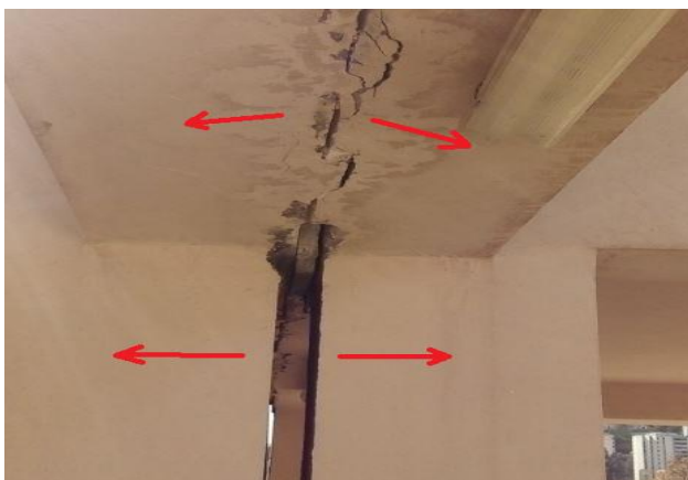
Figure III.6. Fissuration des joints de dilatation et des murs de la ferme pédagogique.
