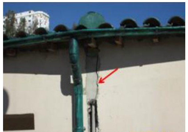
Figure III.6. Fissuration des joints de dilatation et des murs de la ferme pédagogique.
