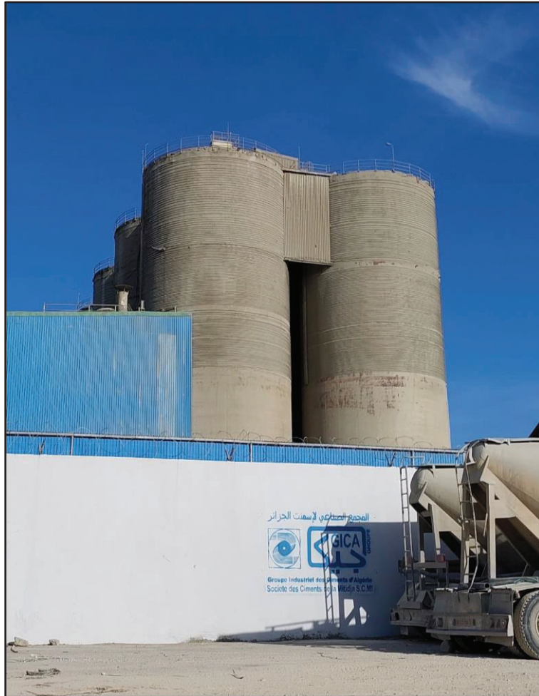
Figure II-6 : photo prise d'un groupe de silo en béton armé - Cimenterie GICA (Meftah-Alger)
