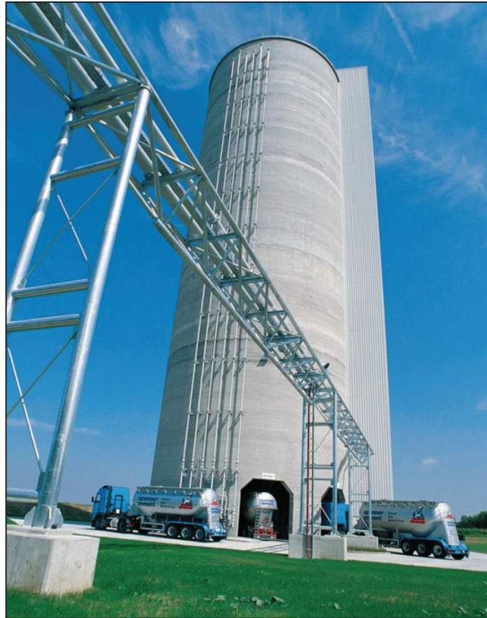
Figure II-11: silo de stockage de ciment multi cellulaire - Allemagne [4]
