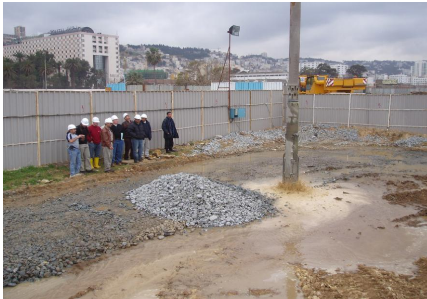
Figure 6.1- Réalisation d'un essai d'information sur le chantier de Hamma (Photo Keller)
