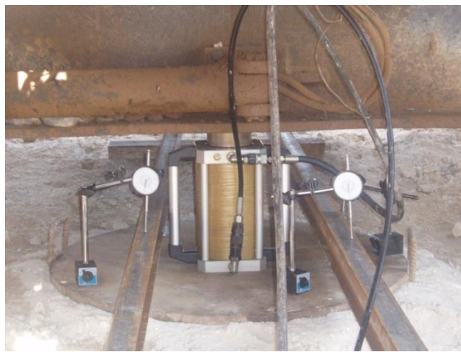
Figure 6.4- Réalisation d'un essai de chargement (Photo Keller Algérie)
