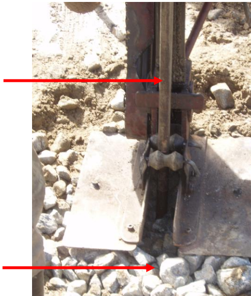
Figure 7.8- Photo montrant l'essai de pénétromètre dynamique (Chantier de Hamma )
