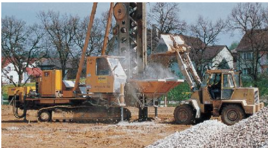
Figure 3.6- Exécution des colonnes ballastées par voie sèche
