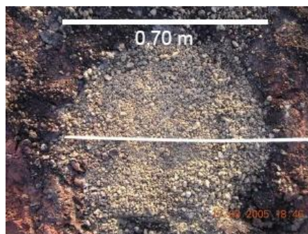
Figure 6.6- Dégarnissage d'une colonne pour vérifier son diamètre
