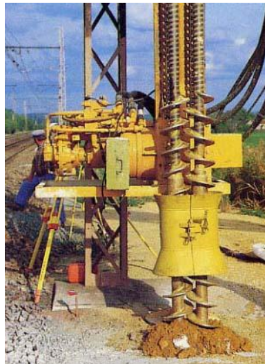
Figure 2.14- Perforation de sol à l'aide de deux tarières [49]
