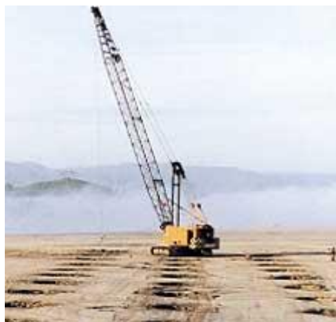
Figure 2.11- Réalisation des plots ballastés (Photo Entreprise G.T.S)
