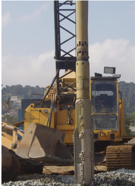
Figure 3.5- Exécution des colonnes ballastées par voie humide au sein de chantier Hamma Water en Algérie (Photo Keller Algérie)
