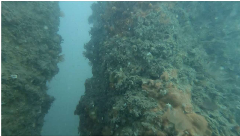
Figure 34.Écartement entre les palplanches.
