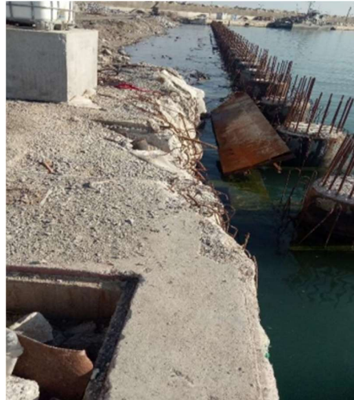
Figure 16. Démolition de la poutre de couronnement.
