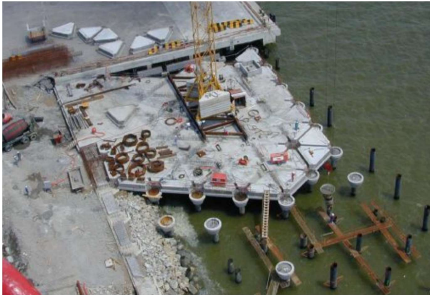
Figure 8.Exemple de réalisation d'une poutre de couronnement.
