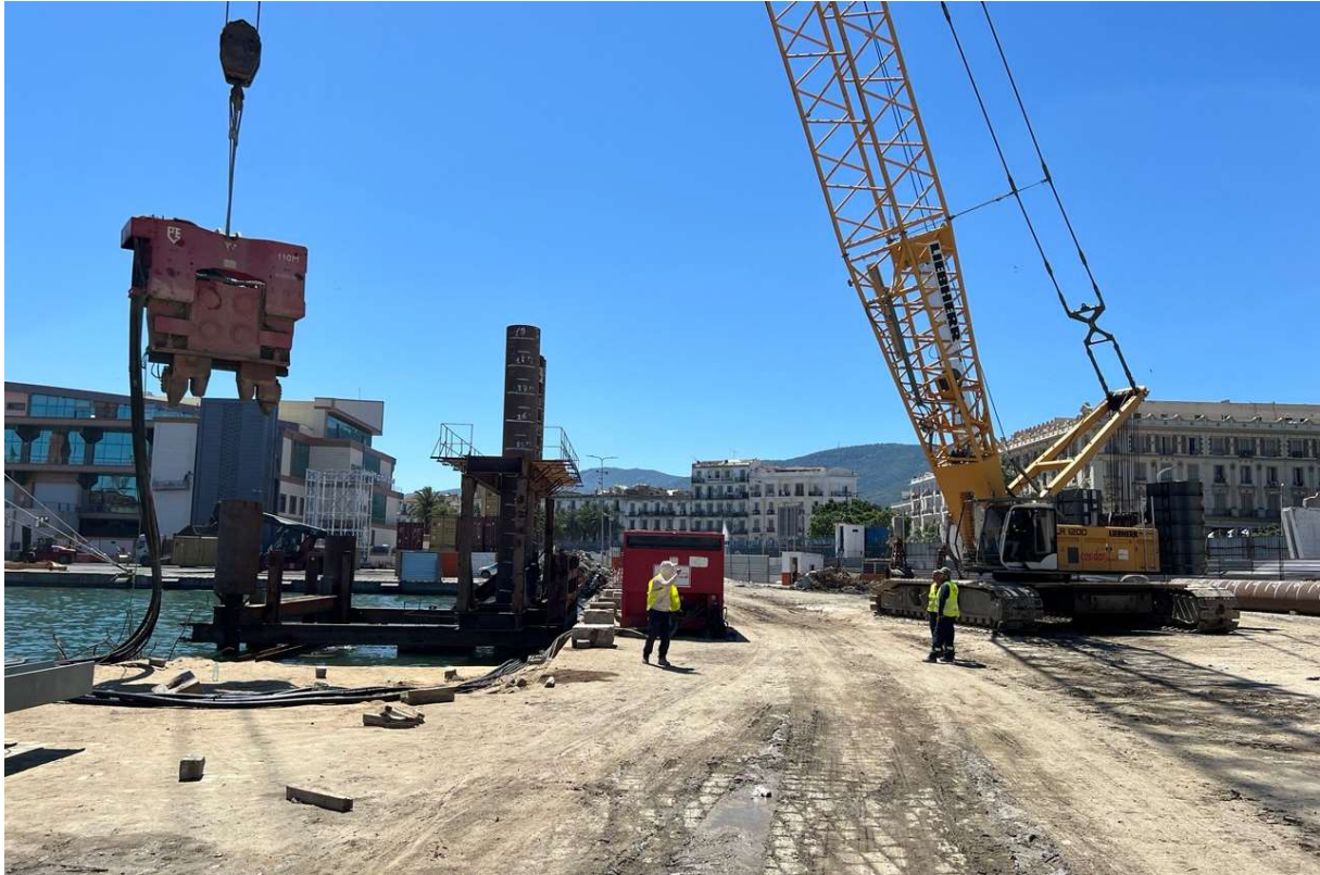
Figure 51. Travaux et géométrie de la situation transitoire 01 sur site.
