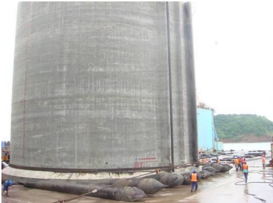
Figure VII.12 : Manutention et déplacement d'un caisson.
