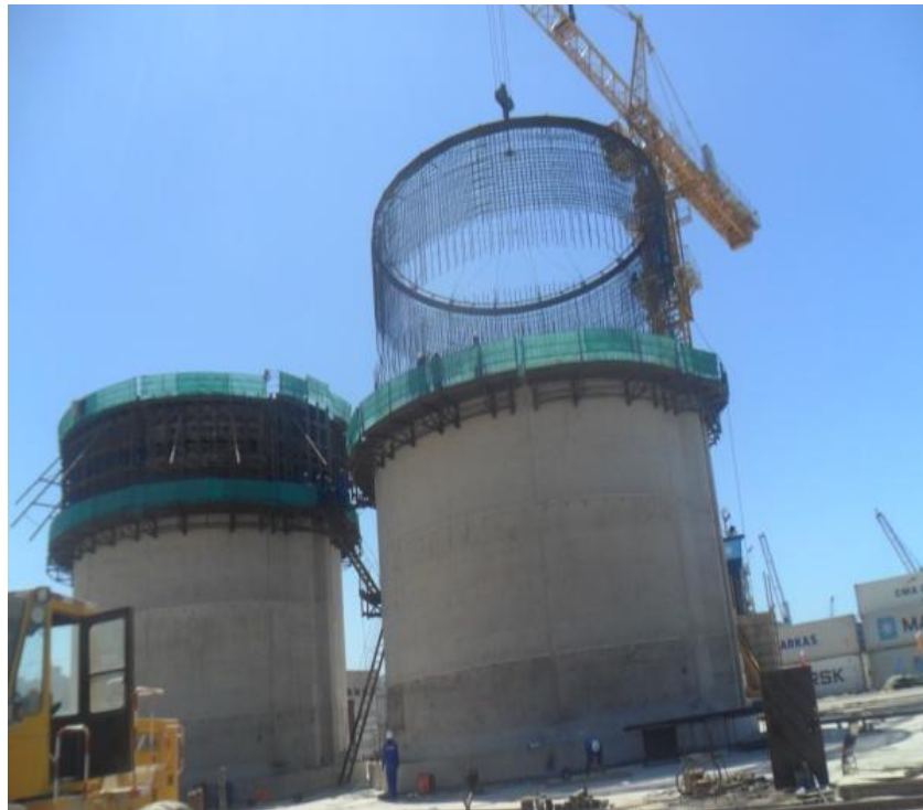
Figure VII.7 : Manutention et montage des ferrillages d'une élévation standard.
