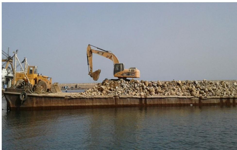
Figure VII.10 : Positionnement et mise en place des enrochements.
