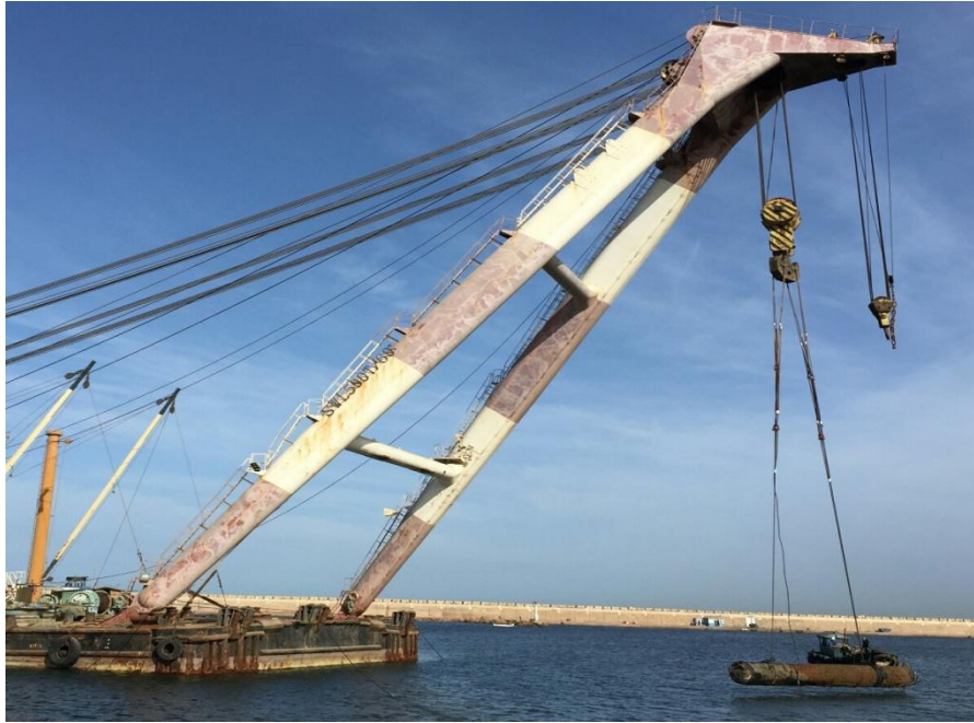
Figure VII.3 : Manutention d'un pieu par un ponton grue.
