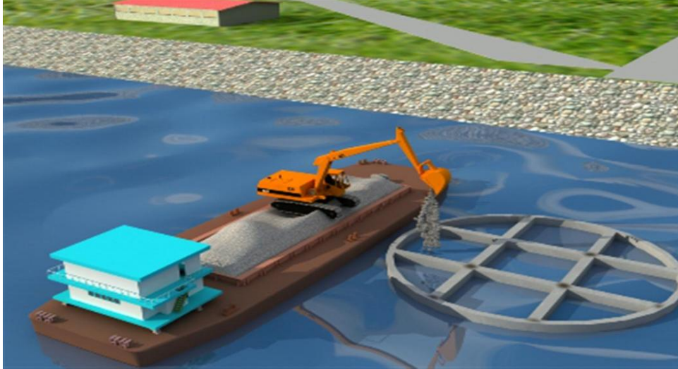
Figure VII.15 : Remblai intérieur d'un caisson.
