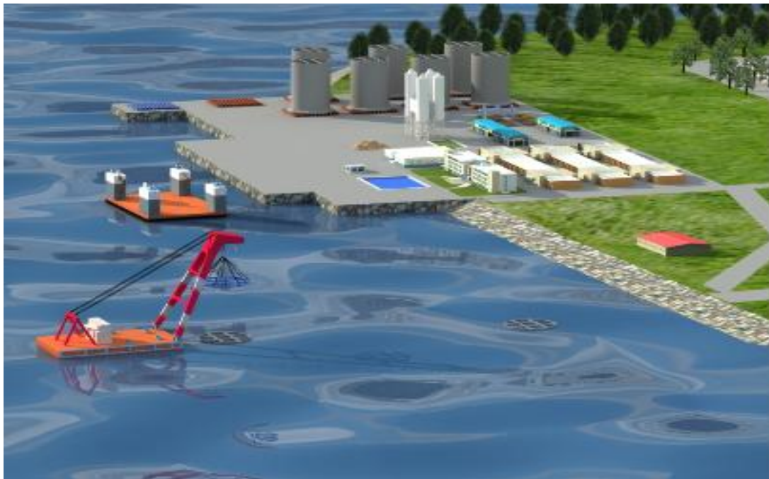
Figure VII.14 : Mise en place d'un caisson.
