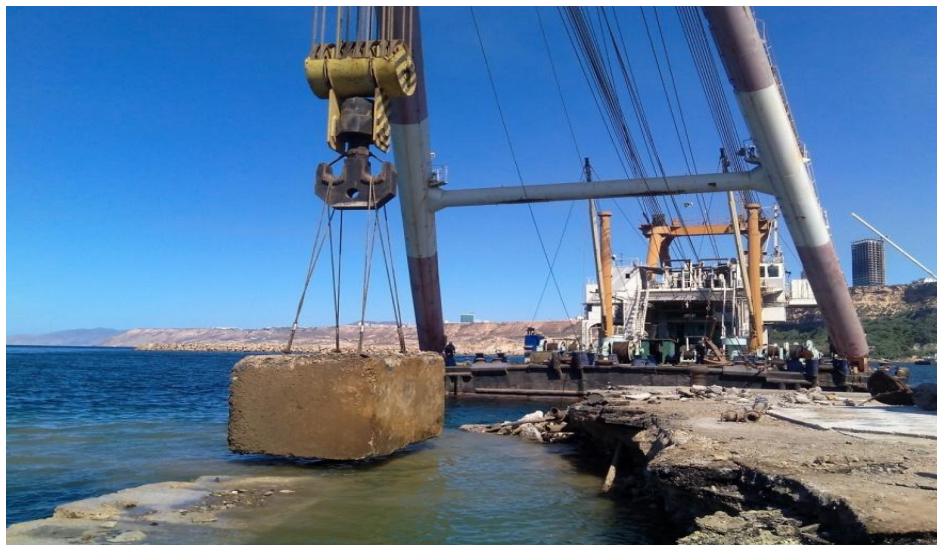
Figure VII.2 : Manutention d'un bloc par un ponton grue.
