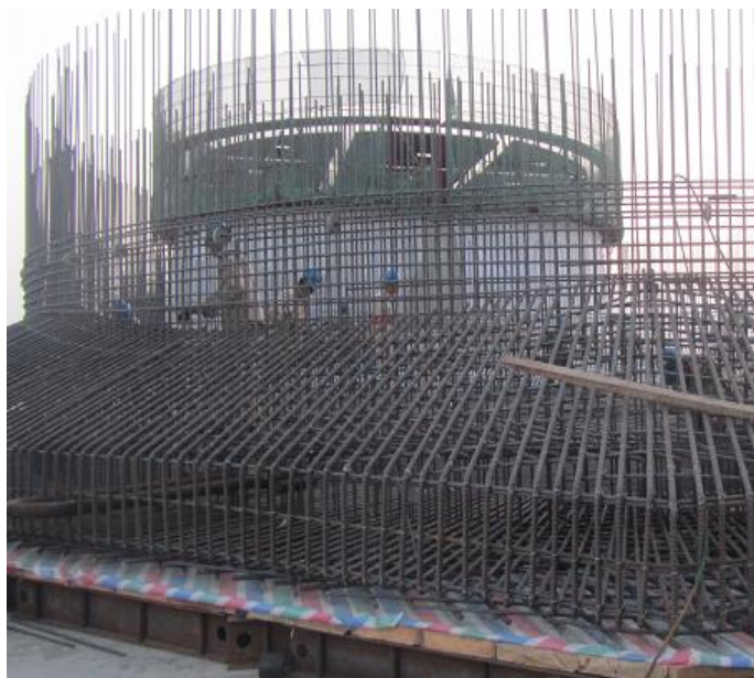
Figure VII.6 : Attachement des ferrailages entre le radier et la première élévation.
