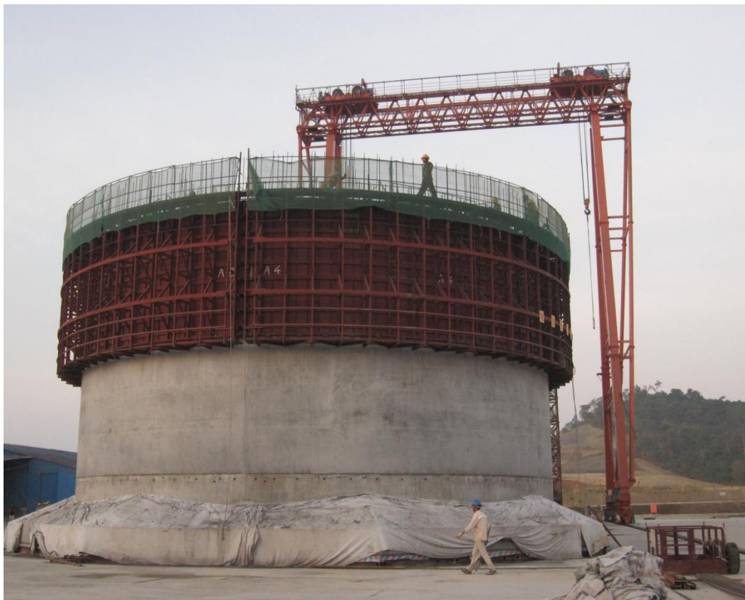
Figure VII.8 : Coffrage d'une élévation standard.
