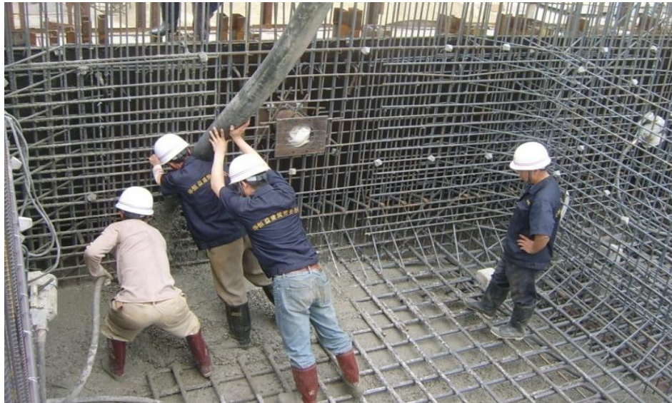
Figure VII.9 : Bétonnage d'une élévation standard.
