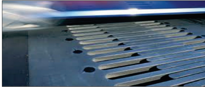
Figure2. Joint de chaussée
